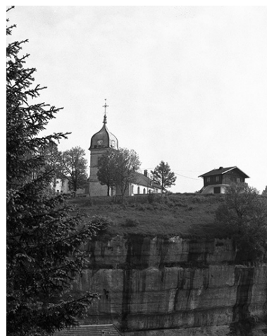
Façade antérieure et face latérale droite. Phot. Yves Sancey IVR43_19752500648X
