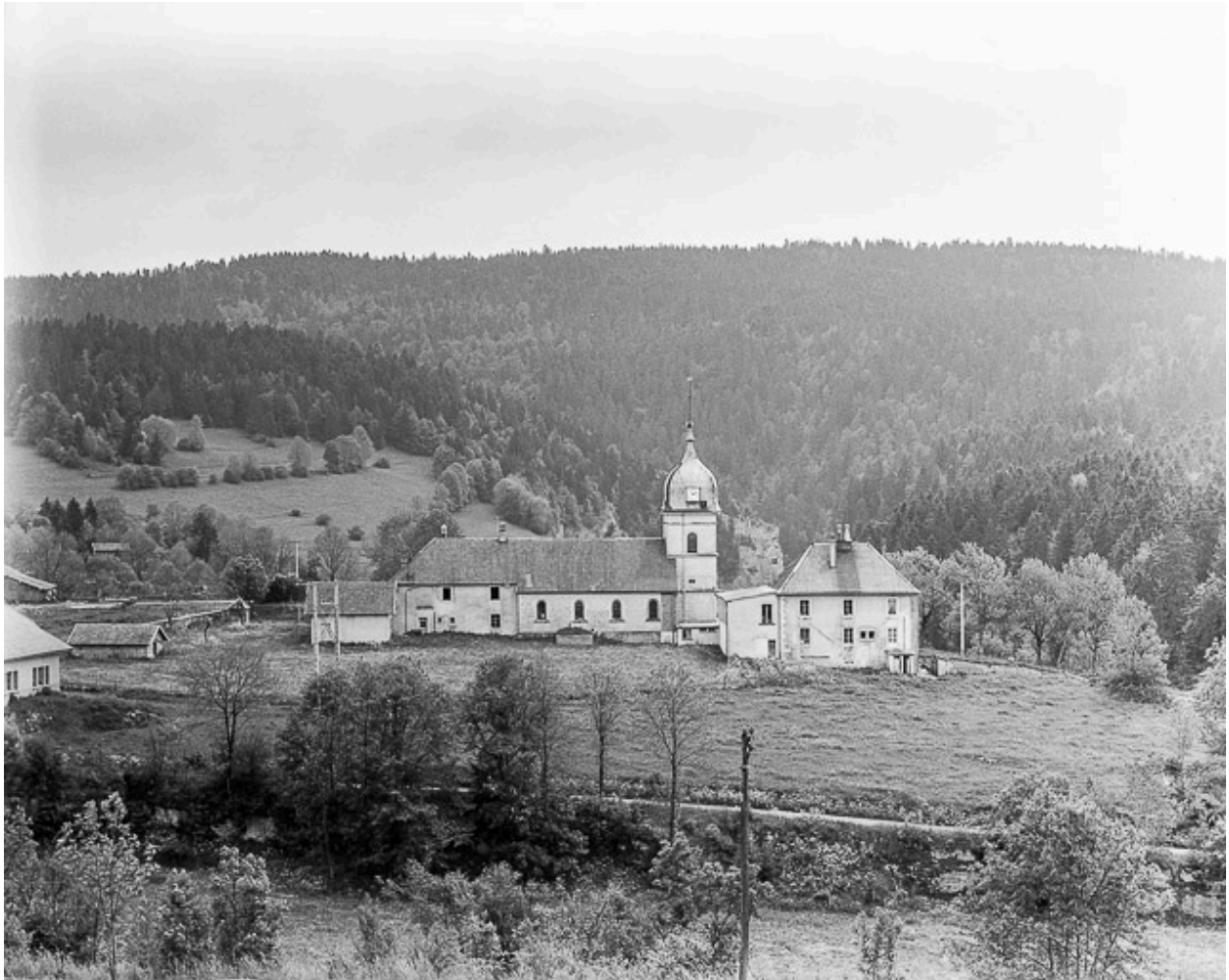
Façade latérale gauche.
