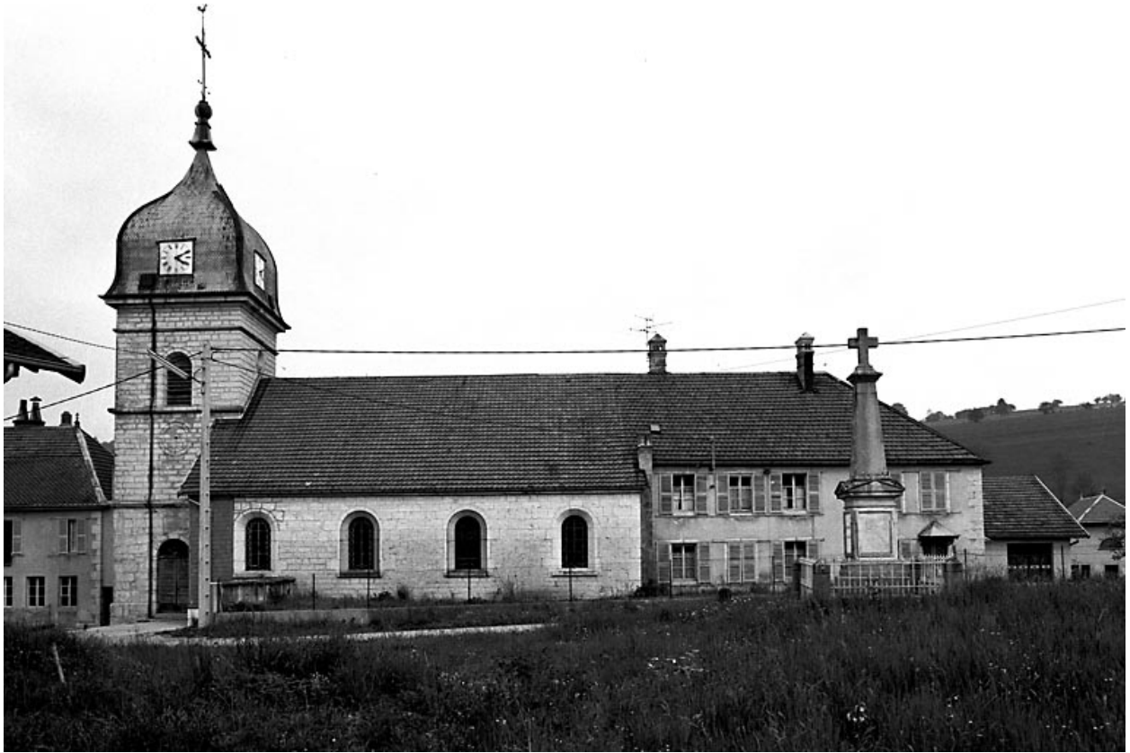
Façade latérale droite.
