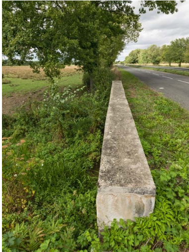
Vue de l'aqueduc. Phot. Pierre-Marie Barbe-Richaud IVR26_20177100279NUC2A
