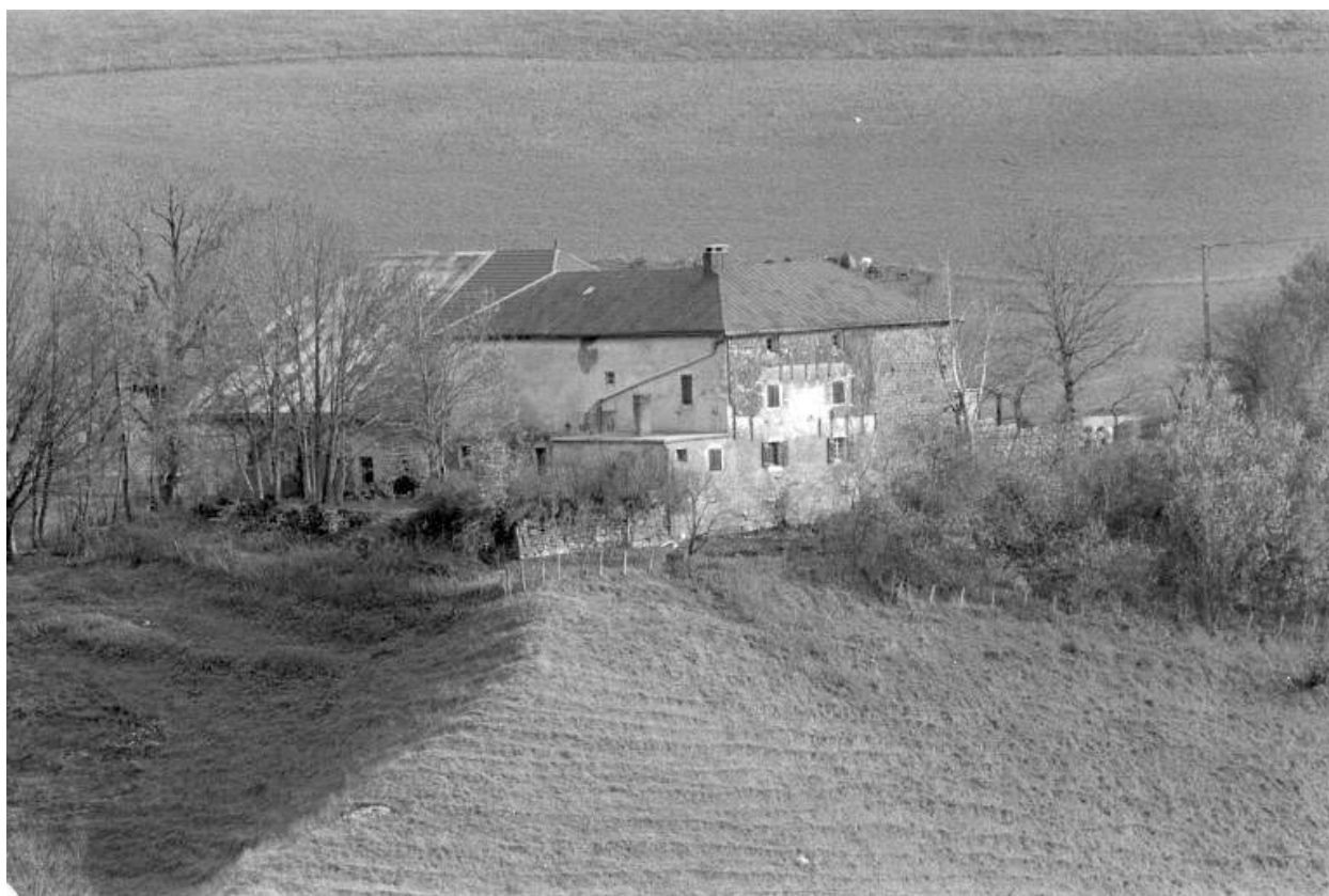
Vue rapprochée de la façade nord-ouest.
