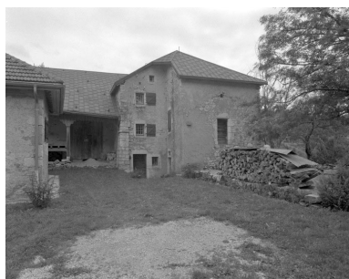
Façade sud-est, partie gauche du bâtiment. Phot. Jérôme Mongreville IVR43_19943900846X
