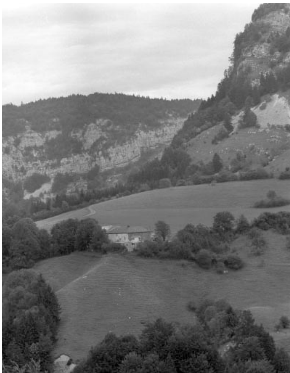
Vue générale, façade nord-ouest.
