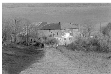
Vue rapprochée de la façade nord-ouest. Phot. Jérôme Mongreville IVR43_19943901281Z
