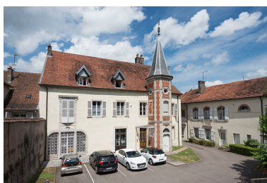
Façade postérieure de la demeure. Phot. Jérôme Mongreville IVR43_20177001031NUC4A
