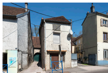
Grange en retrait de la rue. Phot. Jérôme Mongreville IVR43_20177000496NUC4A
