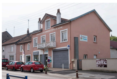
Ancienne station essence, actuellement bureaux de la communauté de communes. Phot. Jérôme Mongreville IVR43_20177000467NUC4A
