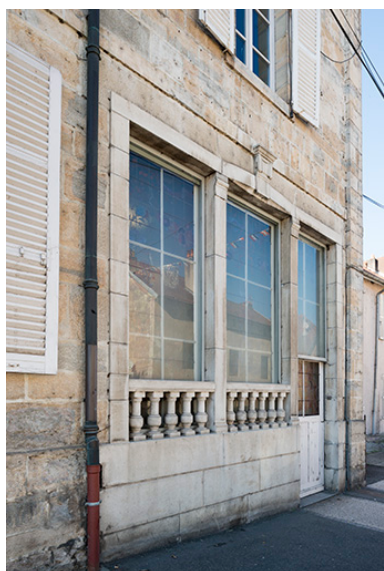
La façade réaménagée de la maison "Petit". Phot. Jérôme Mongreville IVR43_20177001035NUC4A
