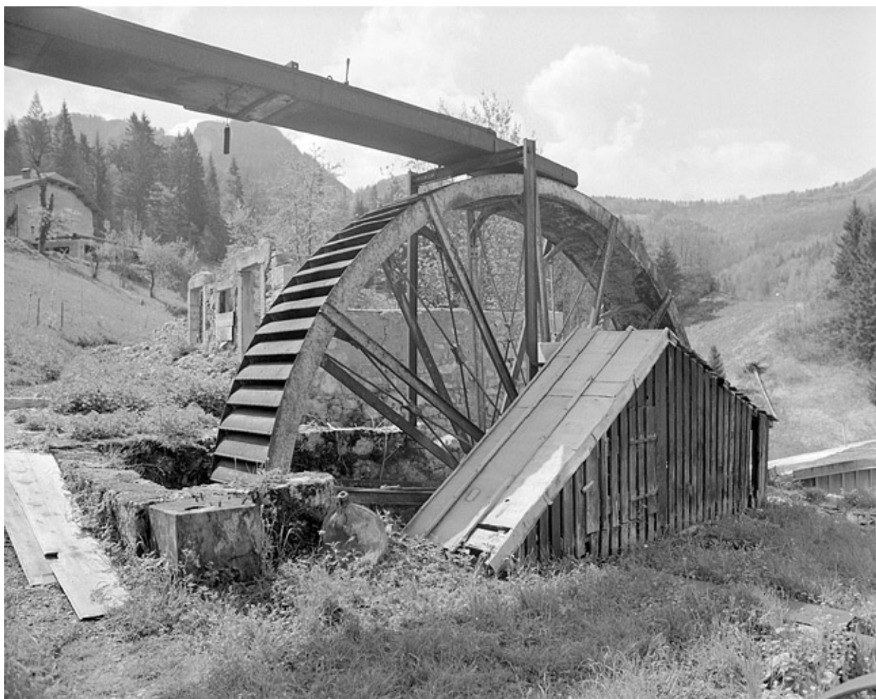
Roue hydraulique et abri du renvoi d'angles.
