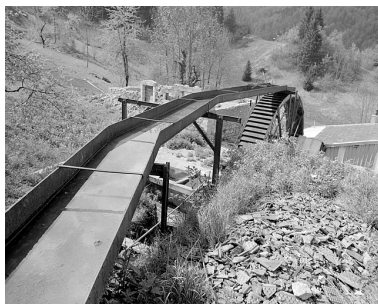
Canal d'amenée métallique et roue hydraulique. Phot. Jérôme Mongreville IVR43_19923900334X
