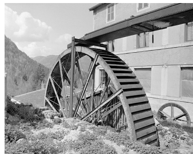
Roue hydraulique. Phot. Jérôme Mongreville IVR43_19923900332X
