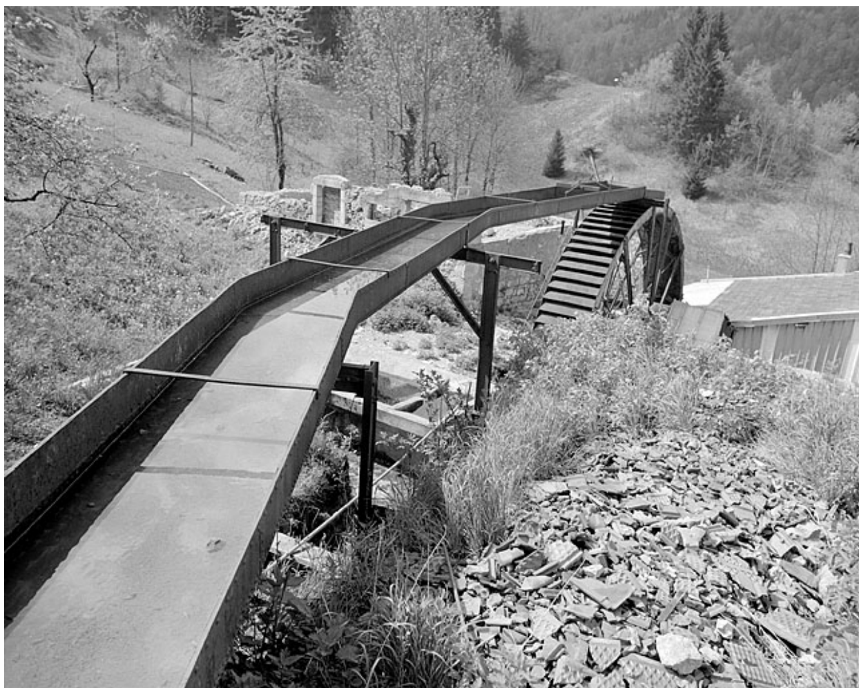
Canal d'amenée métallique et roue hydraulique.
