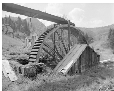
Roue hydraulique et abri du renvoi d'angles. Phot. Jérôme Mongreville IVR43_19923900335X
