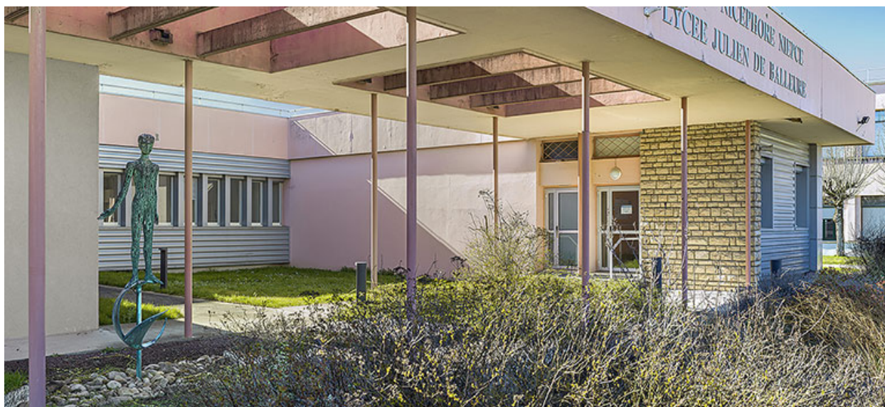
Situation de l'œuvre devant le bâtiment administratif.
