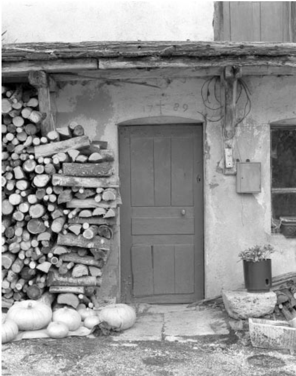
Porte d'accès au logis.
