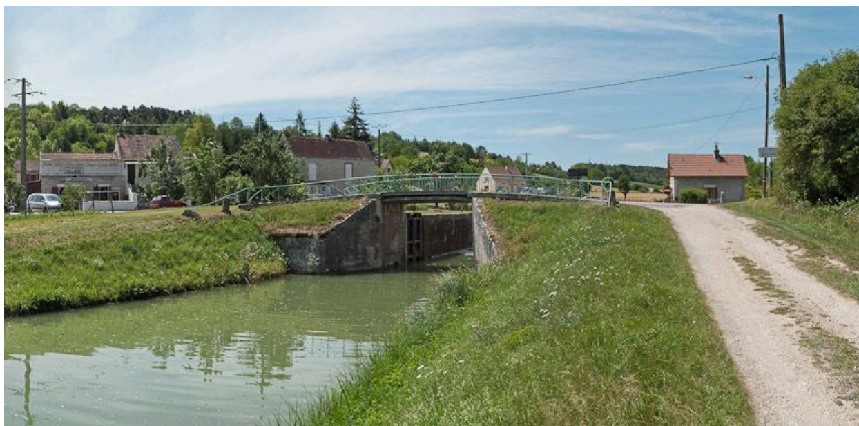
Vue du pont depuis l'aval.
