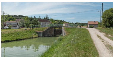
Vue du pont depuis l'aval. Phot. Pierre-Marie Barbe-Richaud IVR26_20118900319NUC4AQ
