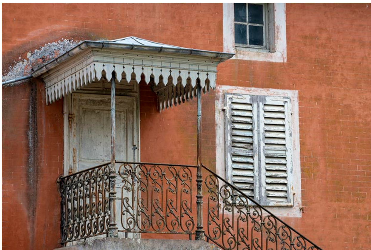
Façade nord, perron.
