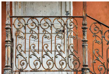
Garde-corps du perron. Phot. Jérôme Mongreville IVR43_20187000808NUC4A
