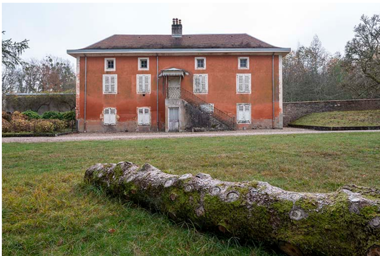
Façade nord, vue d'ensemble.
