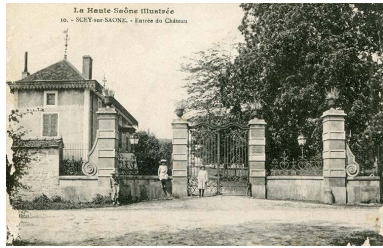
Vue d'ensemble depuis l'est. Autr. auteur inconnu IVR43_20197000231NUC4A
