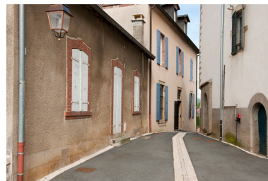
Vue du logis depuis la rue de la Traverse. Phot. Jérôme Mongreville IVR43_20102500674NUC4A
