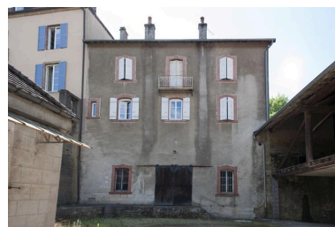
Entrepôt et logis sur cour et entrepôt à fourrage à droite. Phot. Jérôme Mongreville IVR43_20112500393NUC4A
