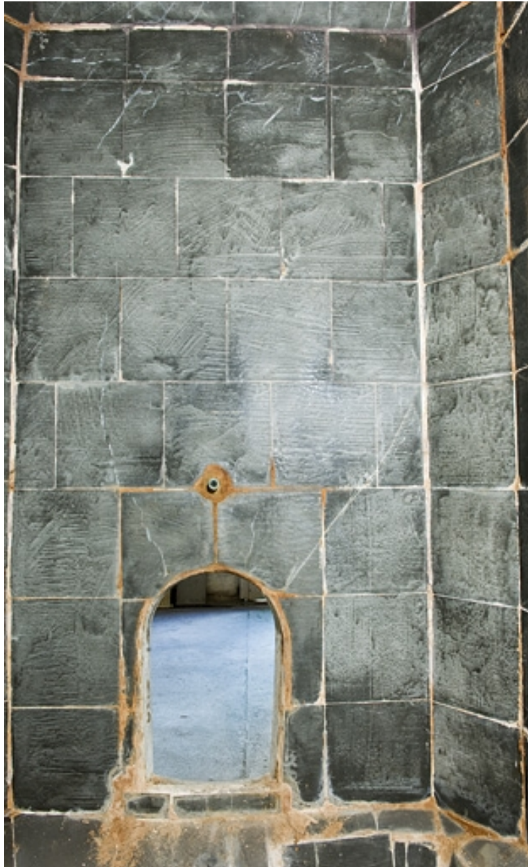
L'ouverture d'une cuve depuis l'intérieur.
