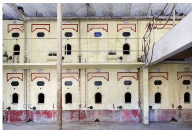
Intérieur de l'entrepôt : vue d'ensemble des cuves depuis l'entrée. Phot. Marc Loukachine IVR43_20112502363NUC4A
