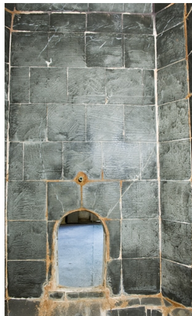
L'ouverture d'une cuve depuis l'intérieur. Phot. Marc Loukachine IVR43_20112502366NUC4A
