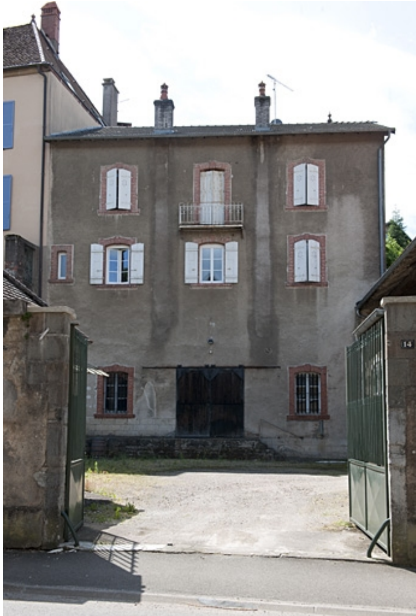
Façade antérieure sur cour, du côté de la rue du Vieux Moulin.
