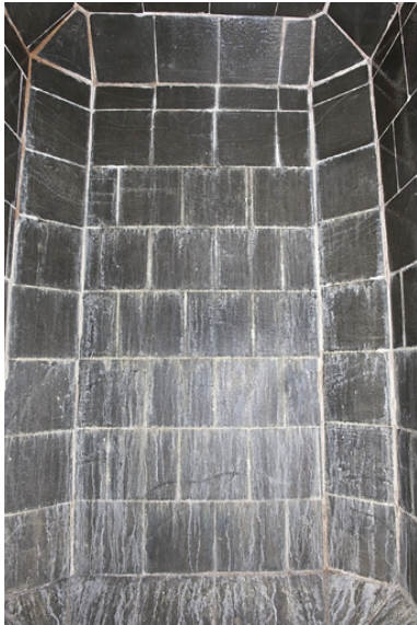
Intérieur d'une cuve. Phot. Marc Loukachine IVR43_20112502367NUC4A
