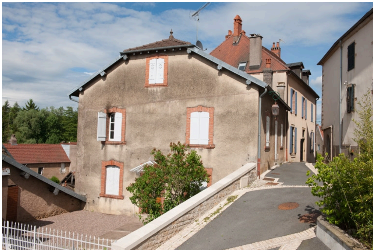
Vue rapprochée depuis la rue de la Traverse.
