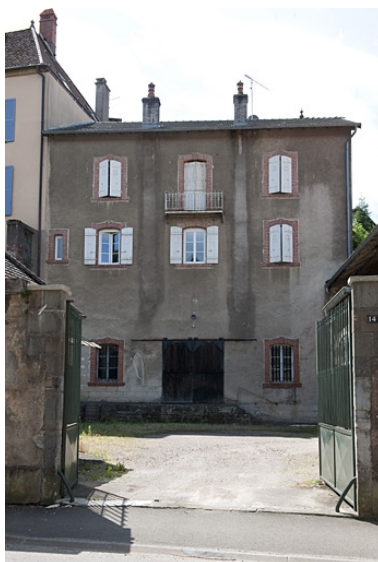
Façade antérieure sur cour, du côté de la rue du Vieux Moulin. Phot. Jérôme Mongreville IVR43_20102501364NUC4A
