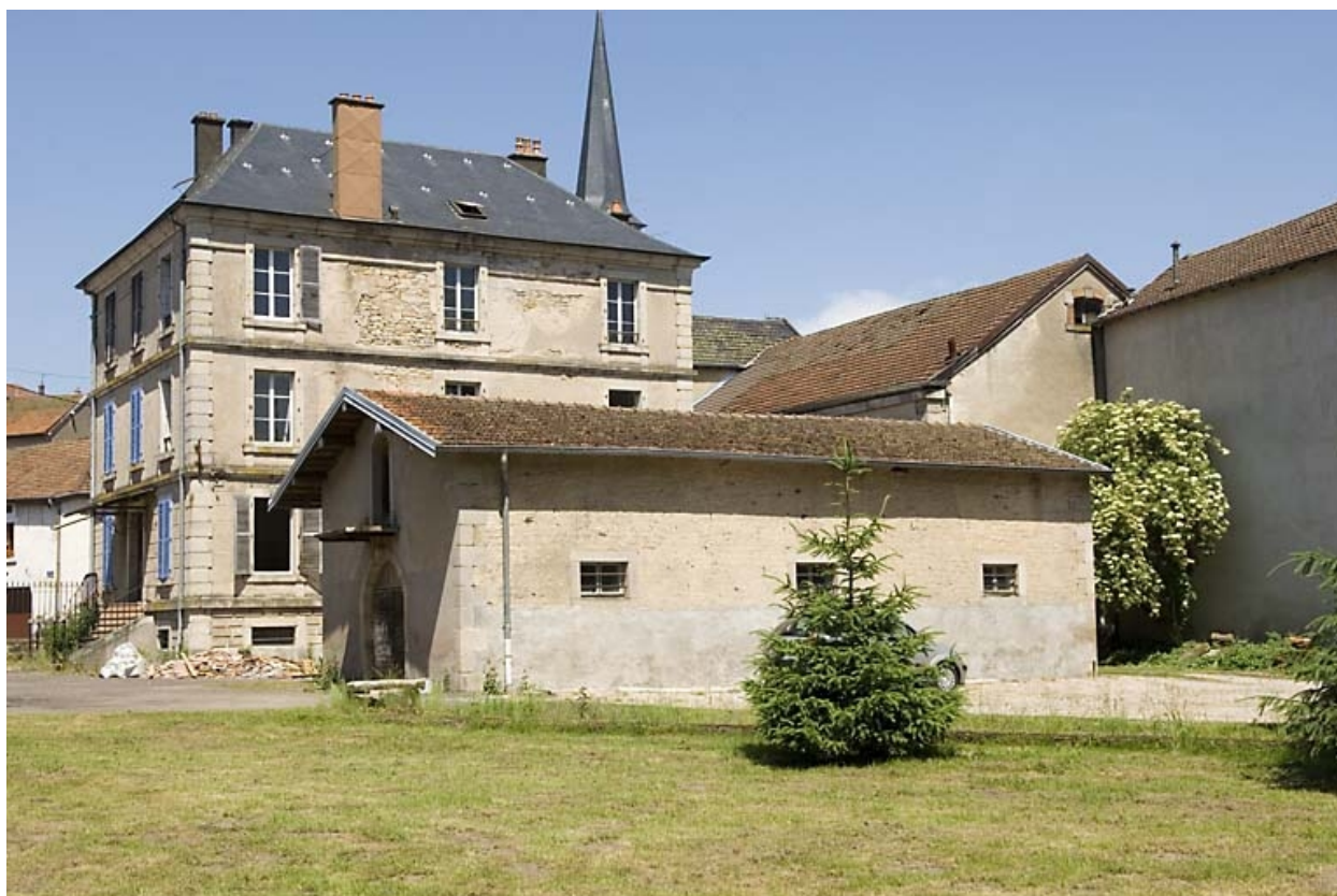
Logement patronal et chai (?) depuis l'ouest.
