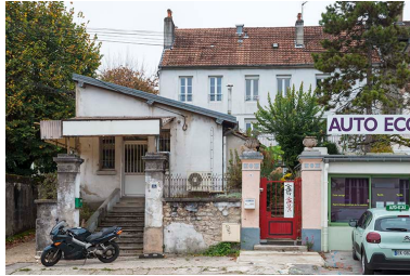
Vue d'ensemble depuis l'avenue. Phot. Jérôme Mongreville IVR43_20172501351NUC4A
