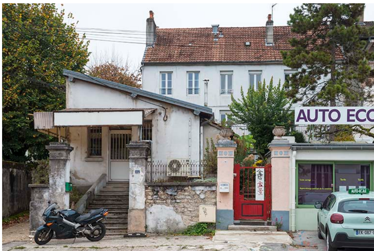
Vue d'ensemble depuis l'avenue.
