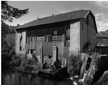
Façade postérieure du moulin Choudet. Phot. Yves Sancey IVR43_19973901172X
