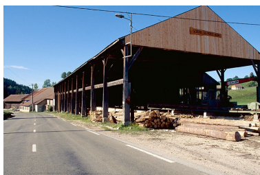
Façades est de la scierie. Phot. Yves Sancey IVR43_19973901182ZA
