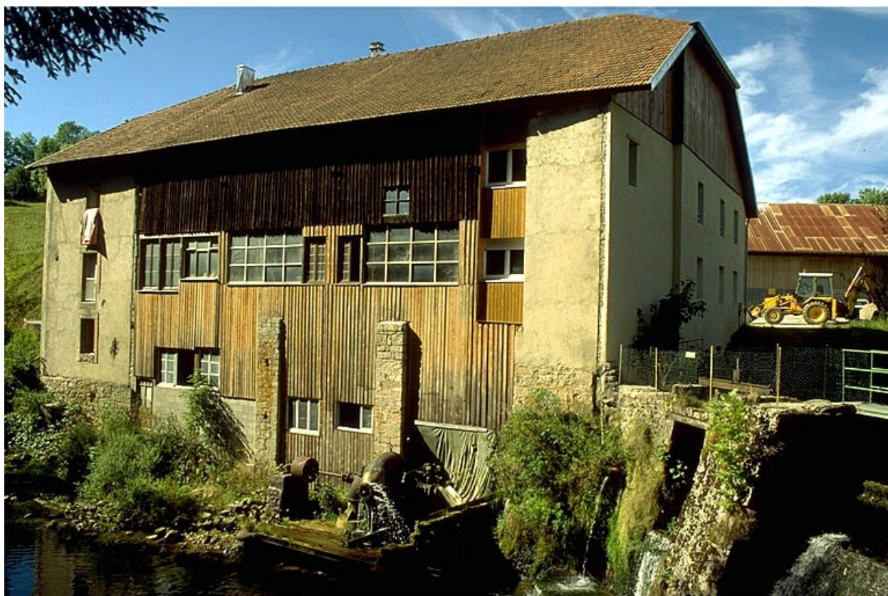
Façade postérieure du moulin Choudet.
