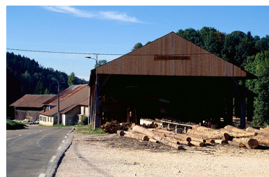
Le parc à grumes couvert. Phot. Yves Sancey IVR43_19973901180ZA
