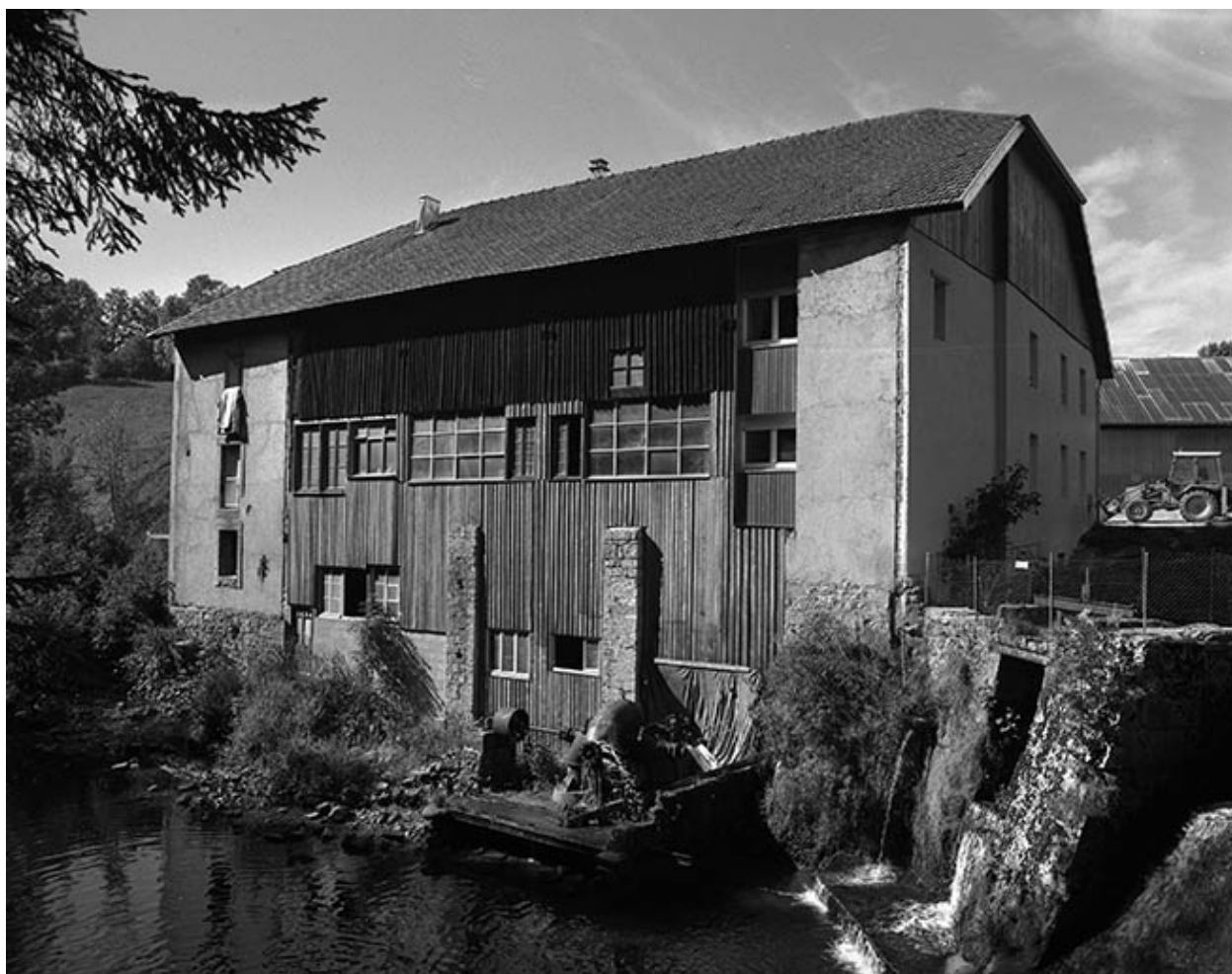
Façade postérieure du moulin Choudet.
