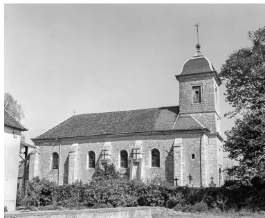
Clocher et face latérale gauche. Phot. Yves Sancey IVR43_19767000330X
