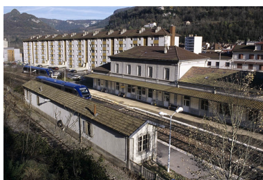
Abri-lampisterie : vue plongeante sur la façade postérieure, de trois quarts droite. Phot. Yves Sancey IVR43_20043900401ZA
