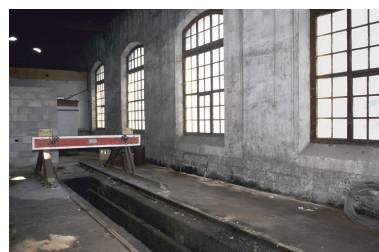
Remise ferroviaire : intérieur de la halle est. Phot. Yves Sancey IVR43_20043900423ZA
