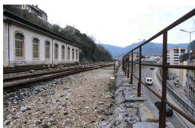
Plate-forme de la gare au niveau de la remise ferroviaire. Phot. Yves Sancey IVR43_20053900818ZA
