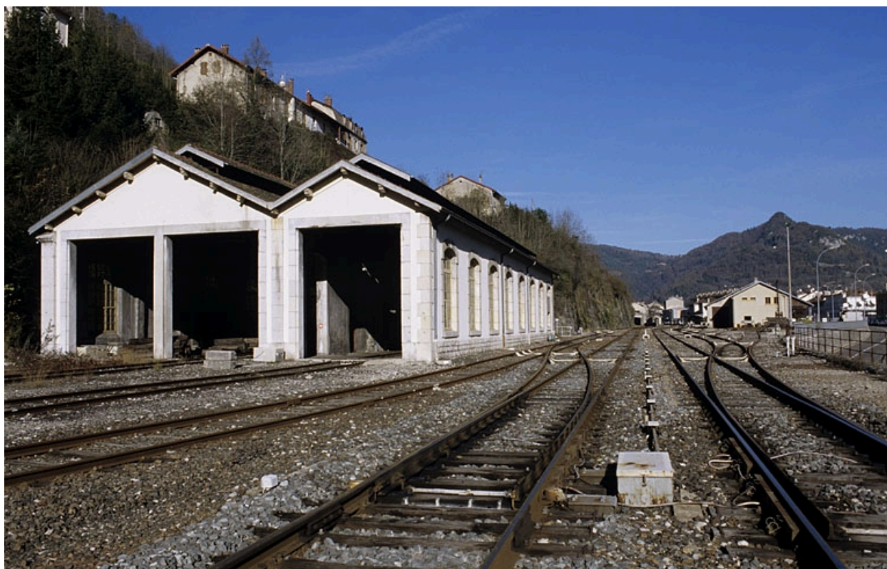
Remise ferroviaire : vue d'ensemble, depuis le sud.
