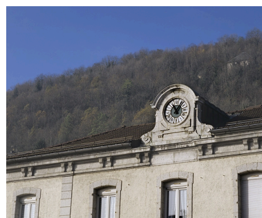
Bâtiment des voyageurs : horloge sur la façade antérieure. Phot. Yves Sancey IVR43_20043900396XA
