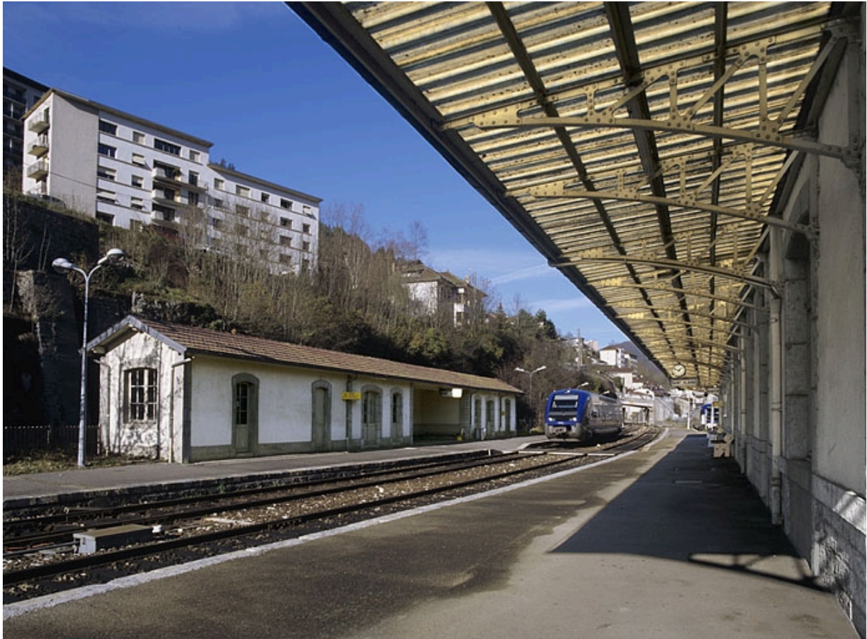
Abri-lampisterie : façade antérieure, de trois quarts gauche.
