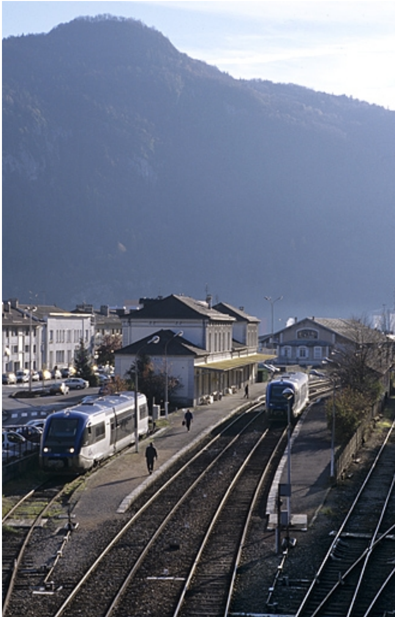
Vue d'ensemble rapprochée depuis le pont routier, au nord.
