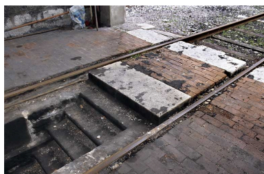
Remise ferroviaire : escalier d'accès à la fosse dans la halle est. Phot. Yves Sancey IVR43_20053900800ZA
