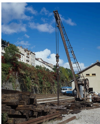
Grue de 6 tonnes, à l'extrémité sud de l'entrepôt. Phot. Jérôme Mongreville IVR43_20013900622XA
