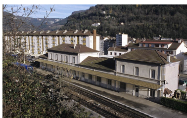
Bâtiment des voyageurs : vue plongeante sur la façade postérieure, de trois quarts droite. Phot. Yves Sancey IVR43_20043900400ZA
