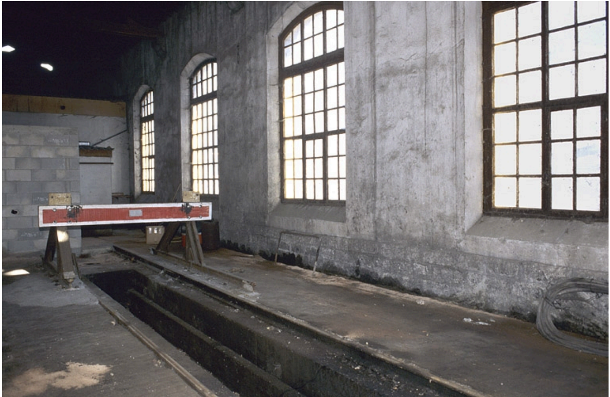
Remise ferroviaire : intérieur de la halle est.
