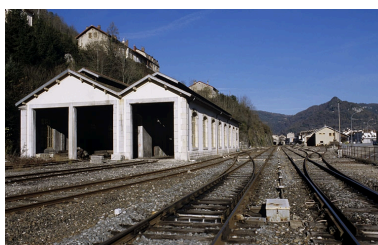
Remise ferroviaire : vue d'ensemble, depuis le sud. Phot. Yves Sancey IVR43_20043900420ZA
