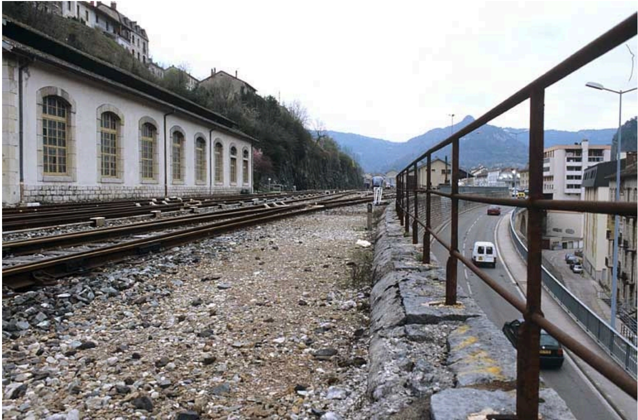
Plate-forme de la gare au niveau de la remise ferroviaire.
