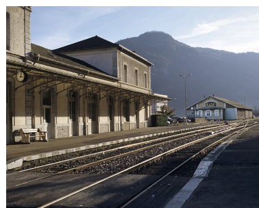
Bâtiment des voyageurs, quais et entrepôt, depuis l'abri-lampisterie. Phot. Yves Sancey IVR43_20043900411XA
