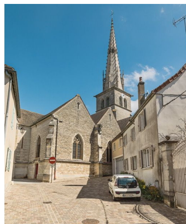
Elévation sud et clocher. Phot. Pierre-Marie Barbe-Richaud IVR26_20172100019NUC2A
