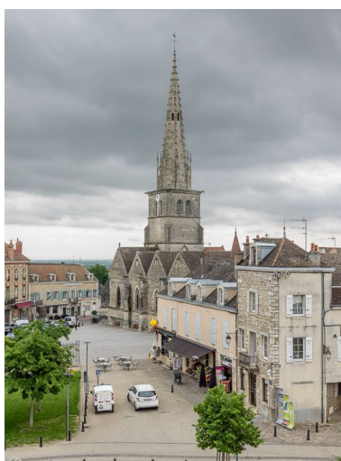
Vue d'ensemble depuis la mairie. Phot. Pierre-Marie Barbe-Richaud IVR26_20172100102NUC2A
