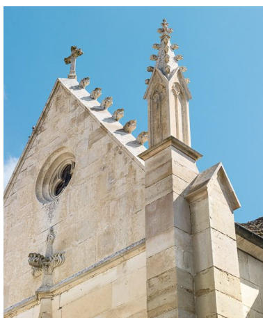
Façade: détail des pinacles et crochets. Phot. Pierre-Marie Barbe-Richaud IVR26_20172100021NUC2A
