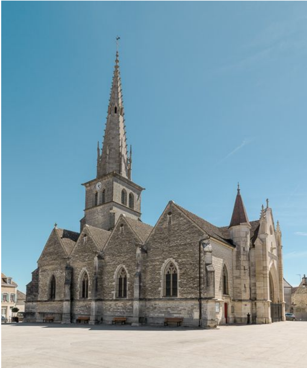
Vue d'ensemble de l'élévation nord.
