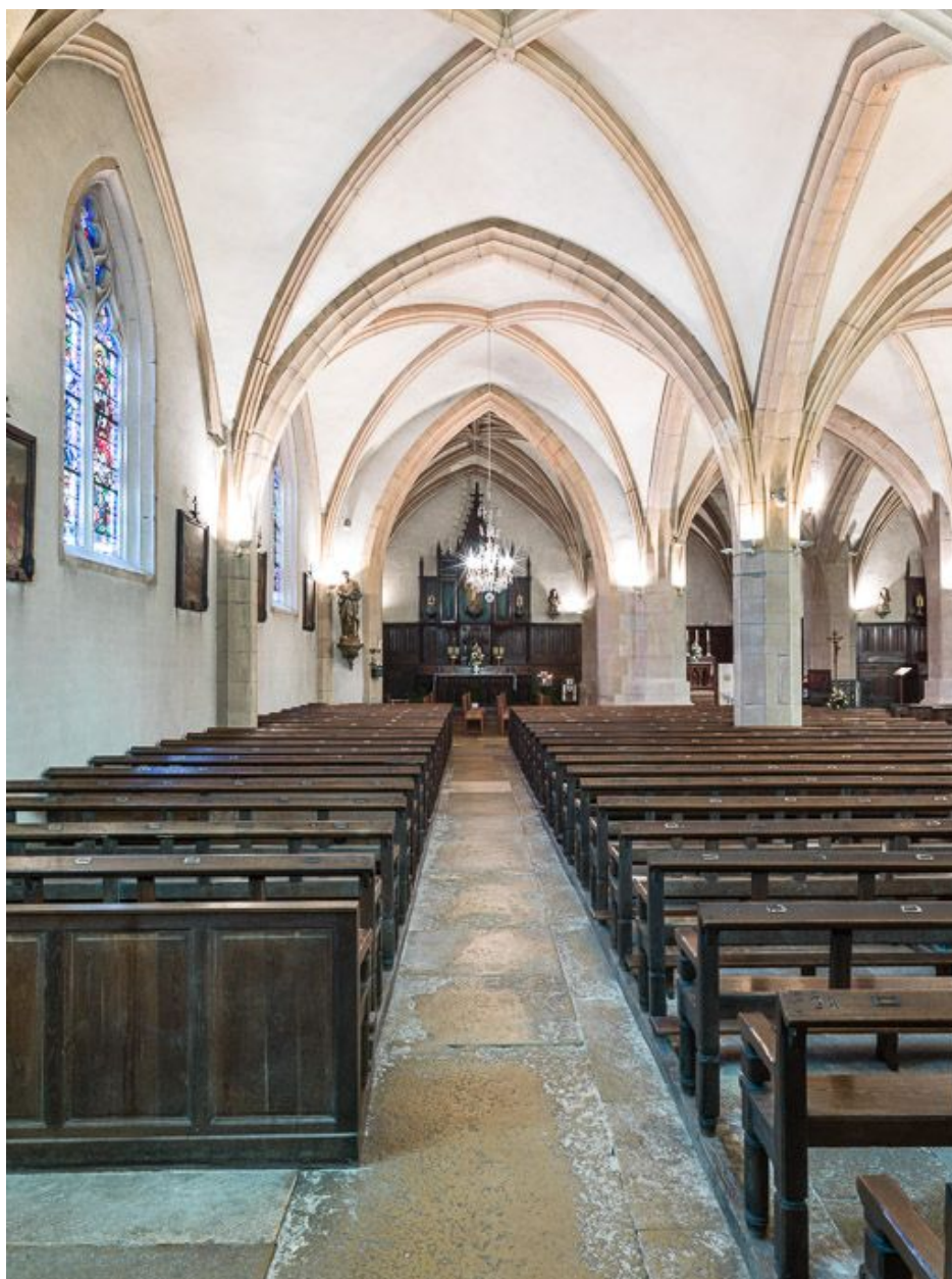
Vue d'ensemble du bas côté nord.
