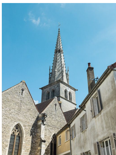
Elévation sud et clocher. Phot. Pierre-Marie Barbe-Richaud IVR26_20172100020NUC2A
