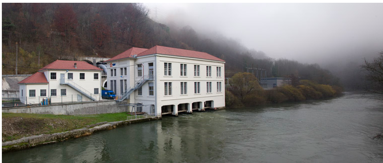
Centrale hydroélectrique : vue d'ensemble, depuis le sud-ouest (aval rive gauche).
