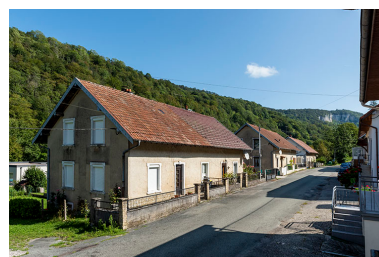
Cité Vauchamp : côté gauche de la rue, avec au premier plan la maison aux n° 123 et 124. Phot. Sonia Dourlot IVR43_20192501441NUC4A
