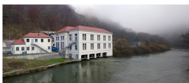
Centrale hydroélectrique : vue d'ensemble, depuis le sud-ouest (aval rive gauche). Phot. Yves Sancey IVR43_20122502014NUC2A
