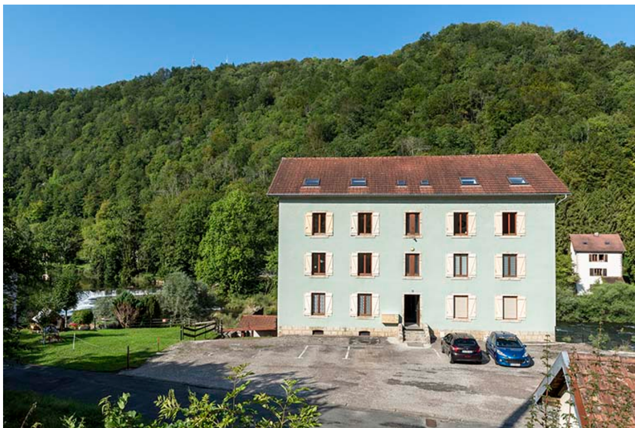
immeuble d'ouvriers du Moulin Neuf, 5 rue du Moulin Neuf à Saint-Hippolyte.
