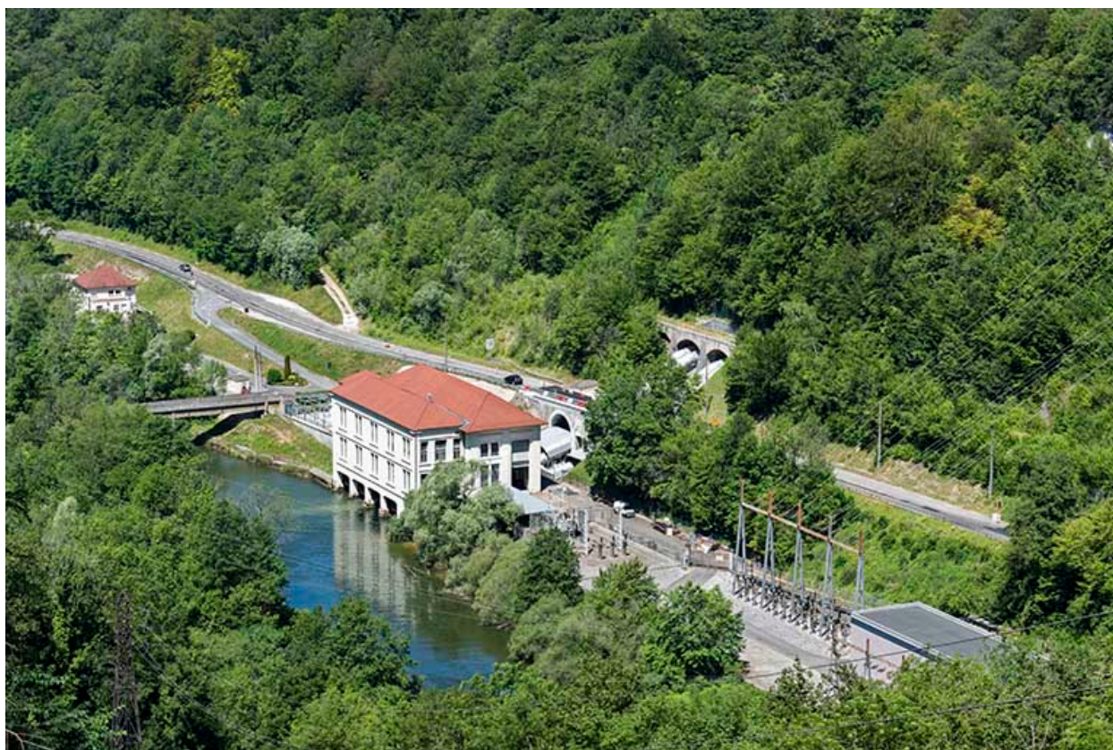
Centrale hydroélectrique au Moulin Artus, Liebvillers : vue d'ensemble plongeante, depuis le sud-est.
