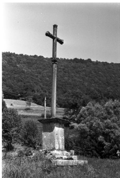
Vue générale. Phot. Guy Forestier IVR43_19743900602Z
