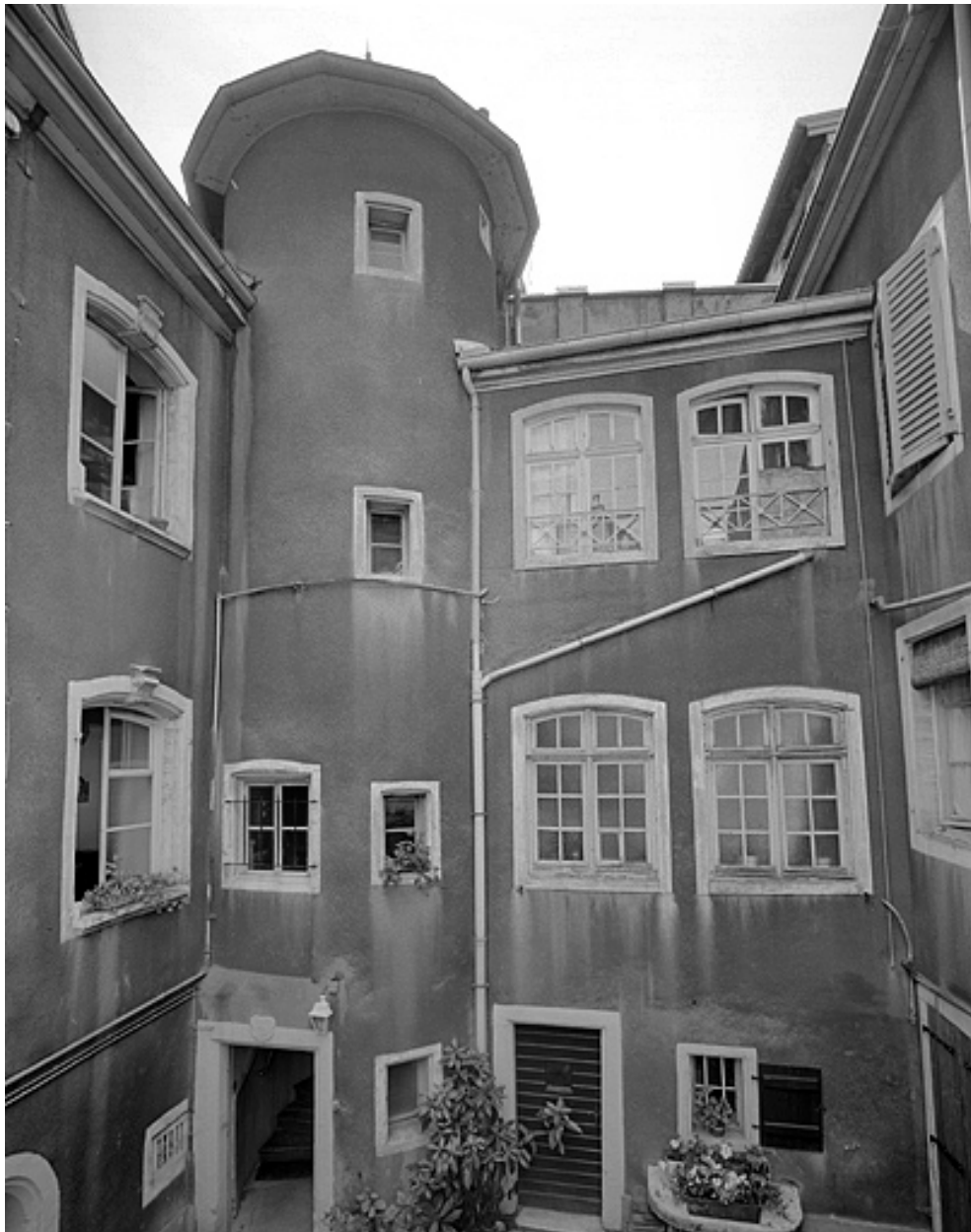
Galleries de liaison et tour d'escalier.
