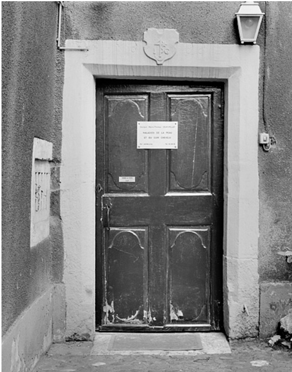
Porte de la tour d'escalier.
