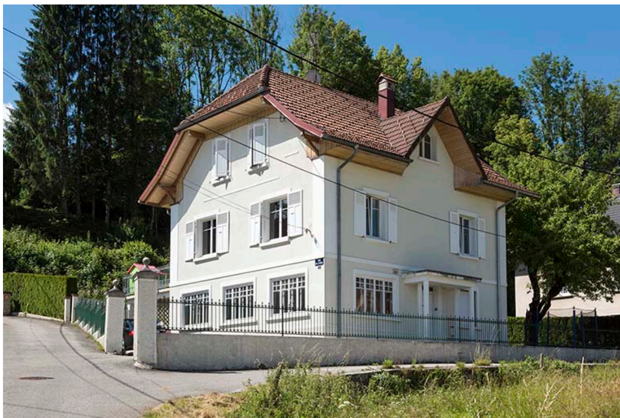
Façades antérieure et latérale gauche.
