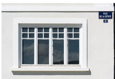
Baie d'atelier. Phot. Sonia Dourlot IVR43_20162500787NUC4A
