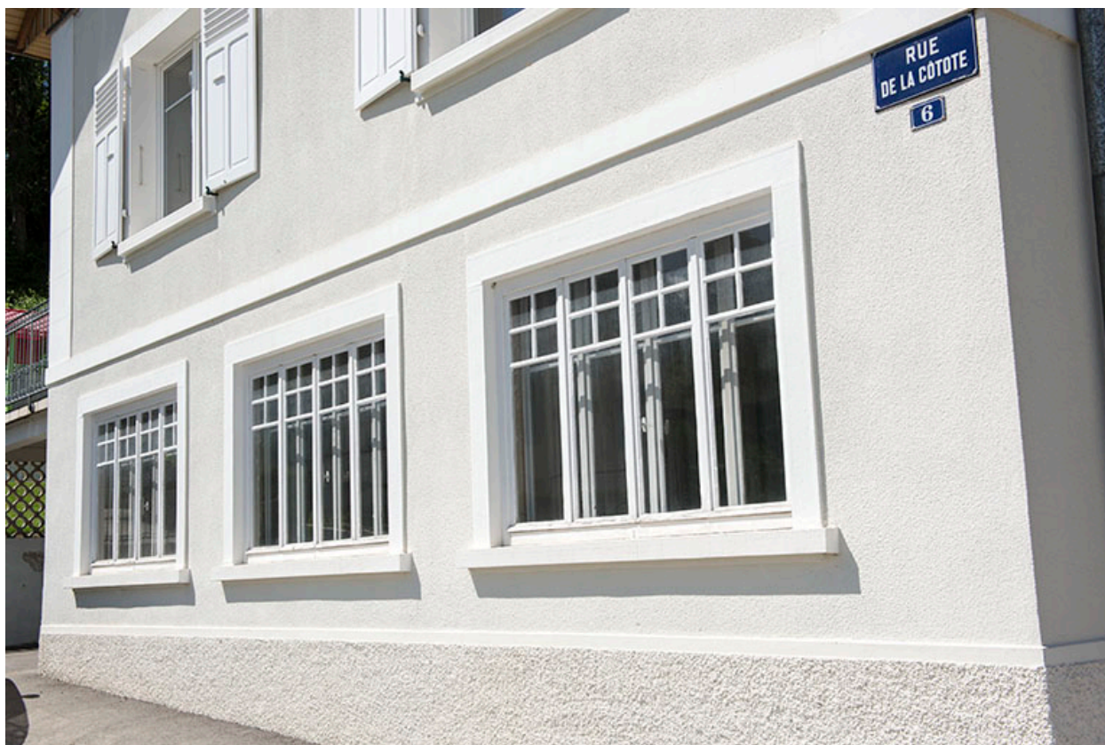
Façade latérale gauche : baies d'atelier.
