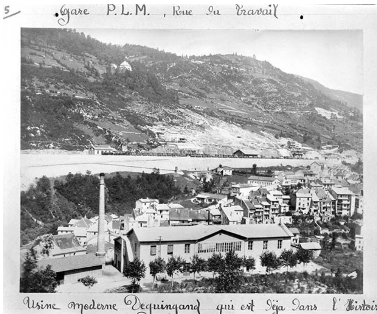
Doc. 01. Vue d'ensemble depuis le sud.
