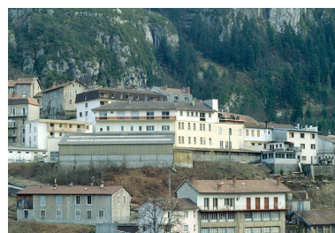
Vue d'ensemble depuis le nord. Phot. Laurent Poupard IVR43_19923901454ZA
