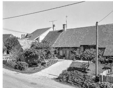
Ferme située rue du Centre.
