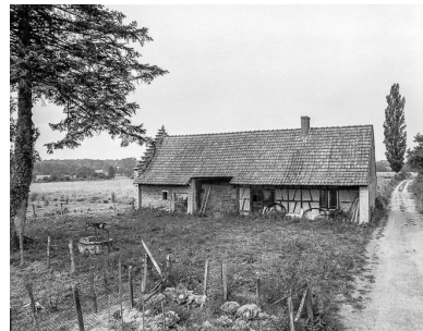
Ferme située au lieudit Les Prés. Phot. Yves Sancey IVR43_19843900033X
