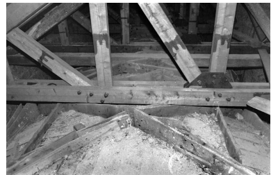
Extrados de la fausse voûte d'arêtes de l'un des bas-côtés. Phot. Jérôme Mongreville IVR43_20003900733Z
