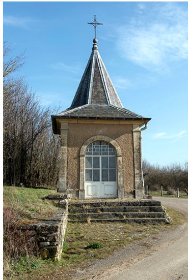
Façade antérieure ouest. Phot. Sonia Dourlot IVR43_20197000279NUC4A
