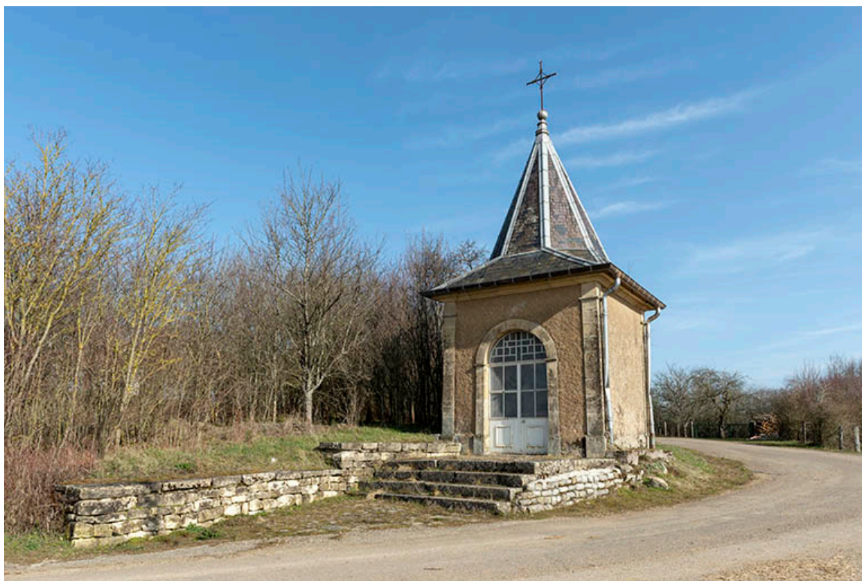
Vue de trois quart depuis l'ouest.
