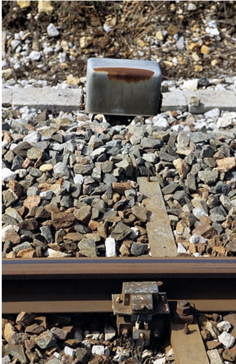
Pédale électronique : vue d'ensemble. Cette pédale commande le contrôle de zone d'un passage à niveau.
