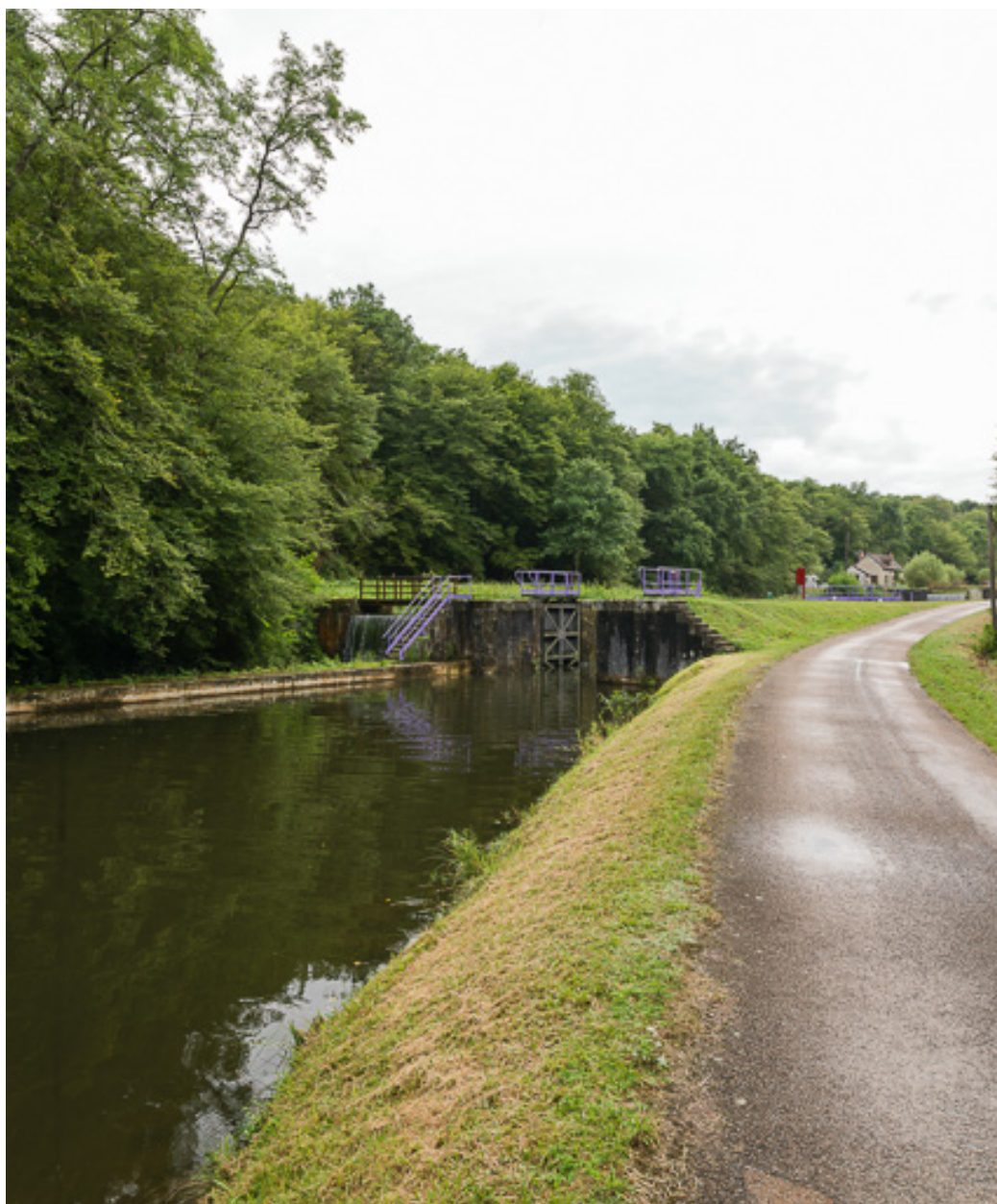
Vue du déversoir de superficie.
