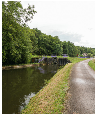
Vue du déversoir de superficie. Phot. Pierre-Marie Barbe-Richaud IVR26_20175800257NUC2A
