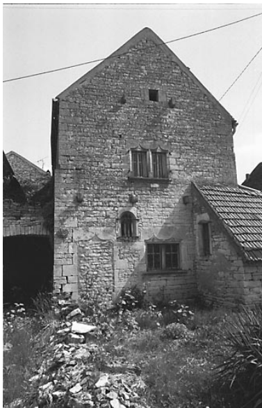
Vue du pignon sur rue. Phot. Bernard Lardière IVR43_19817000314Z
