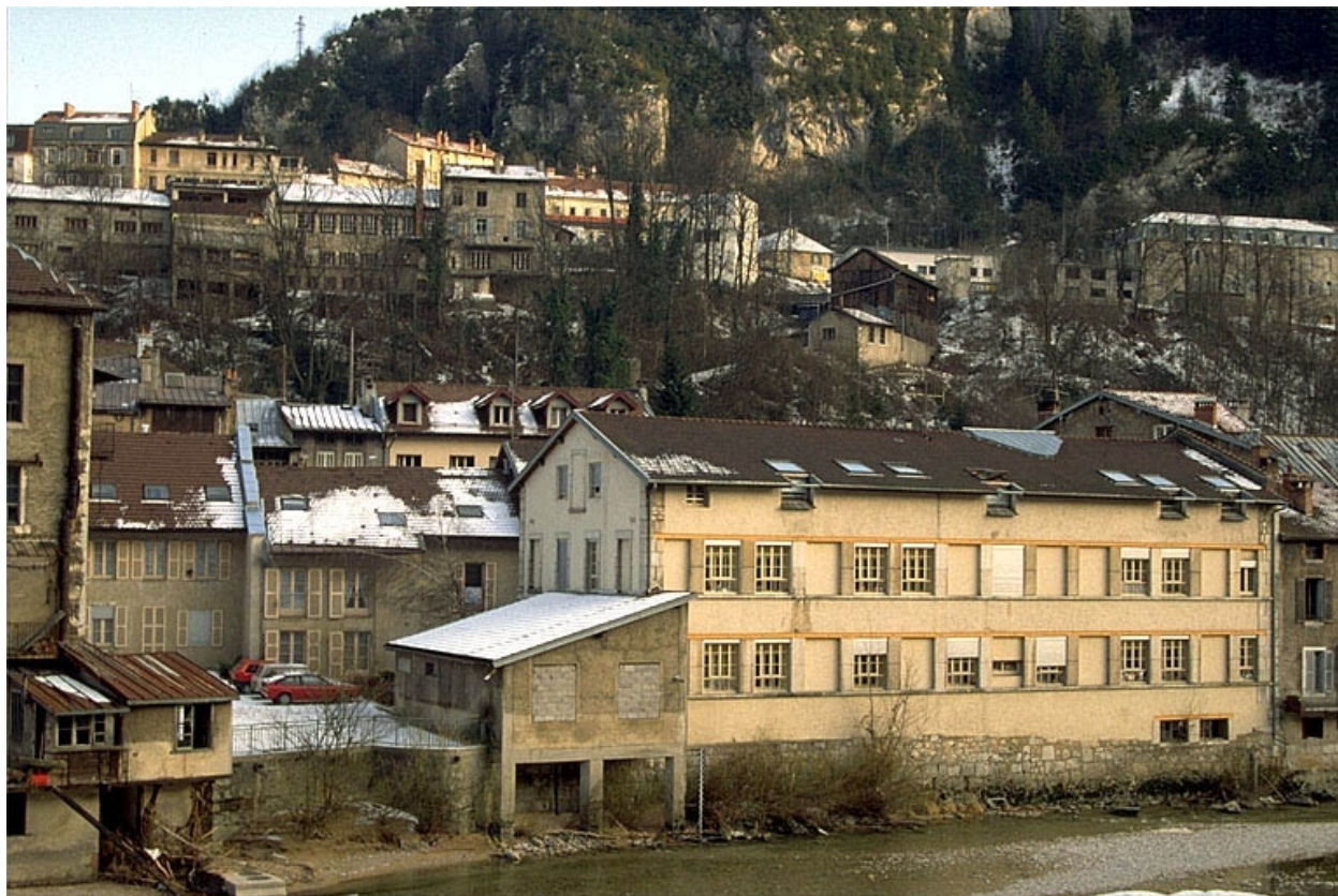
Façade postérieure de l'usine.
