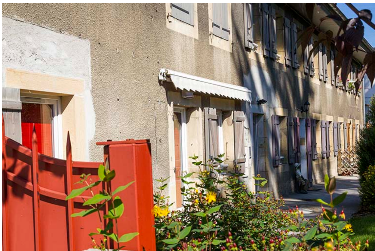
Façade latérale droite.
