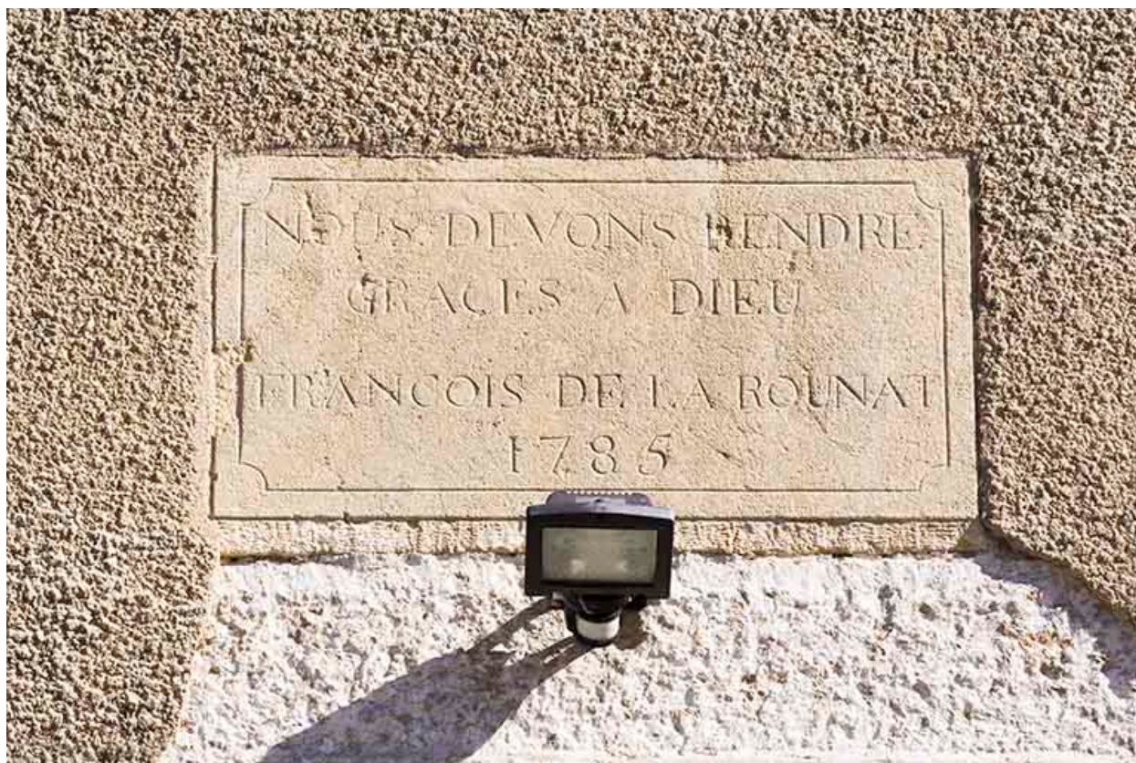
Façade latérale gauche : inscription et date 1785.
