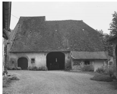
Façade antérieure. Phot. Dominique Dominguez IVR43_19803900010X
