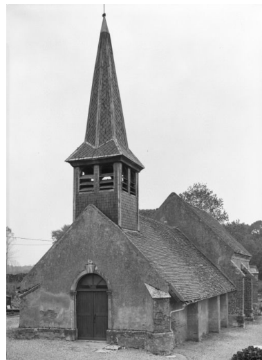
Elévation antérieure Phot. Michel Thierry IVR26_19862101138V
