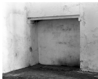
Chapelle seigneuriale, mur gauche, cheminée Phot. Jean-Luc Duthu IVR26_19862101160X
