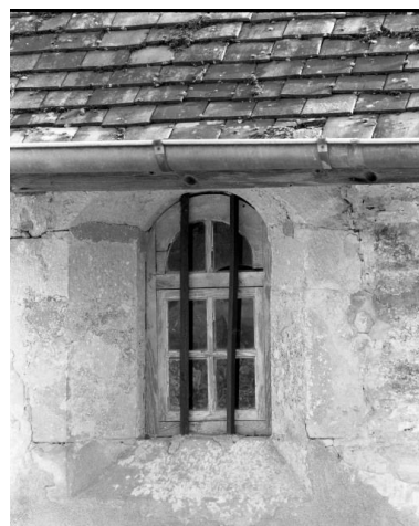
Elévation gauche, 1ère fenêtre de la nef Phot. Jean-Luc Duthu IVR26_19862101147X
