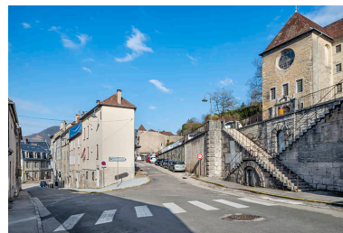
Façade sur la rue Charles Magnin, vue d'ensemble. Phot. Jérôme Mongreville IVR43_20223900323NUC4A
