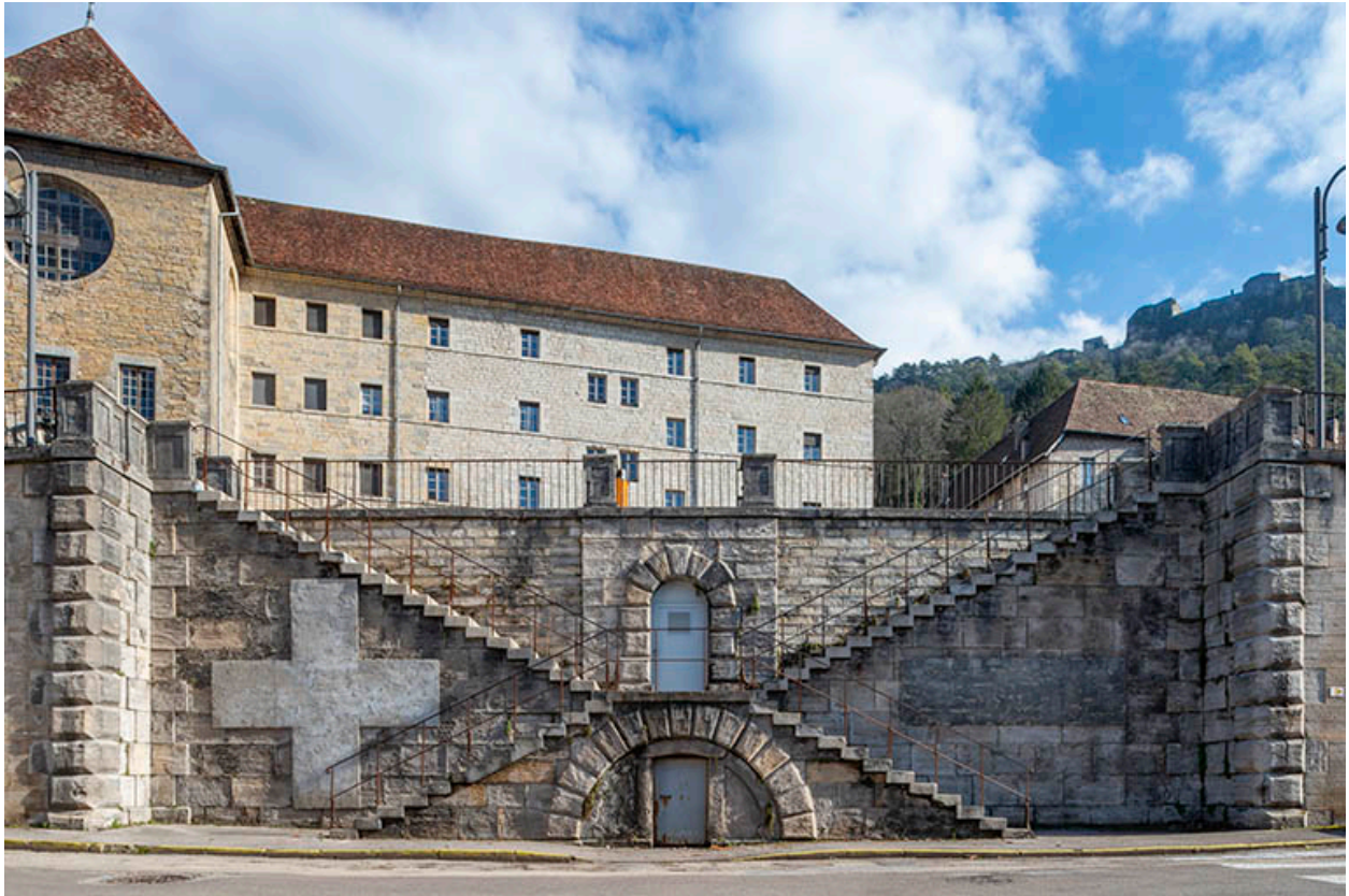
Façade sur la rue Charles Magnin, vue rapprochée de face : escalier.
