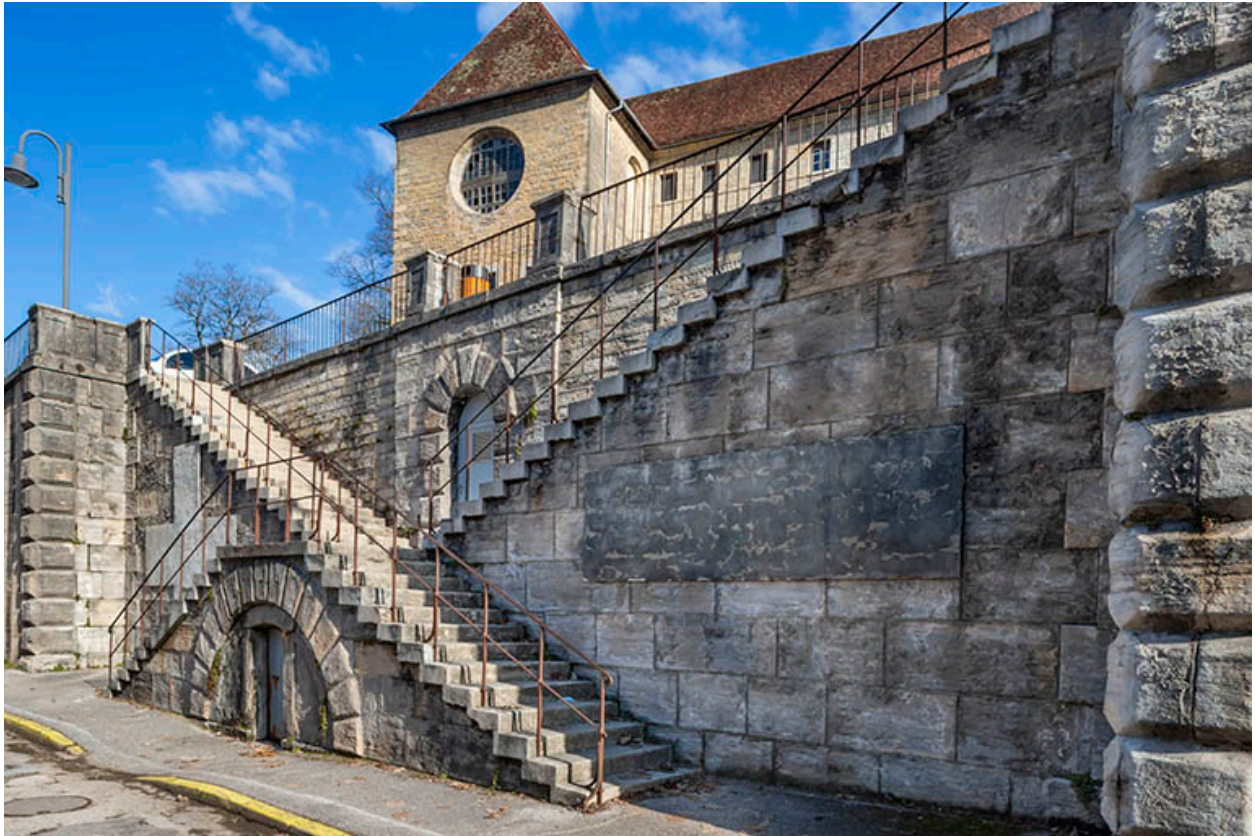
Façade sur la rue Charles Magnin, vue rapprochée de trois quarts : escalier.
