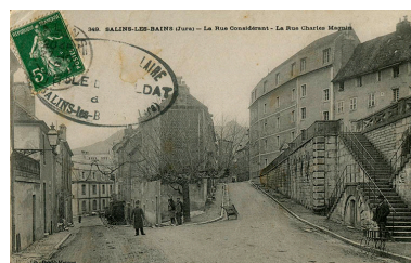
Vue de la façade sur la rue (vers 1910). Autr. auteur inconnu IVR43_20223900065NUC4A
