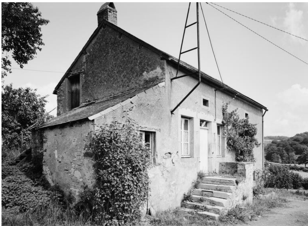
Détail de l'escalier du logis.
