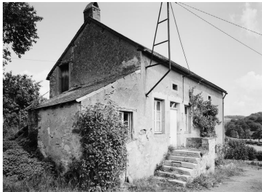
Détail de l'escalier du logis. Phot. Michel Rosso IVR26_19785800156V
