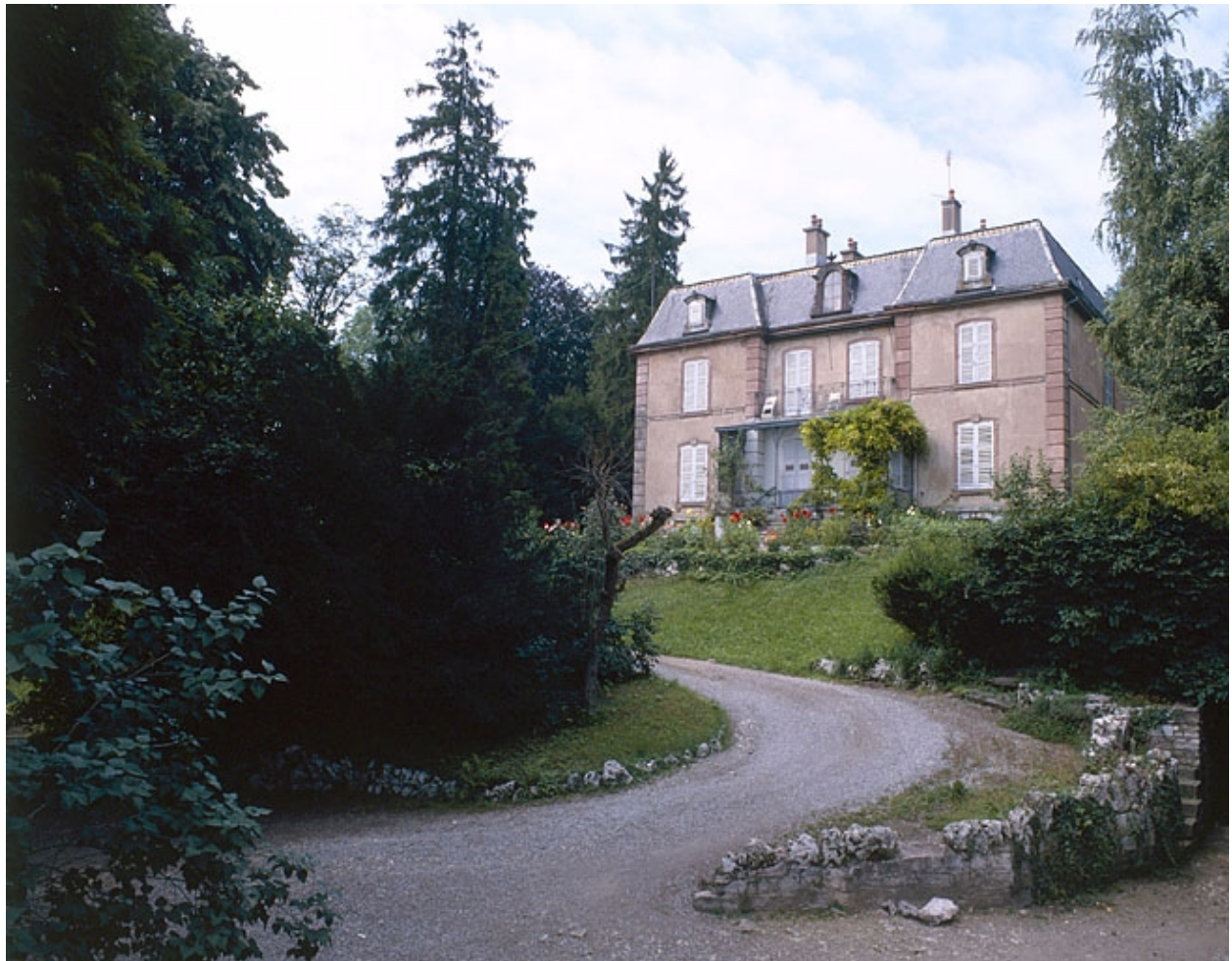
Vue d'ensemble du corps de bâtiment principal.
