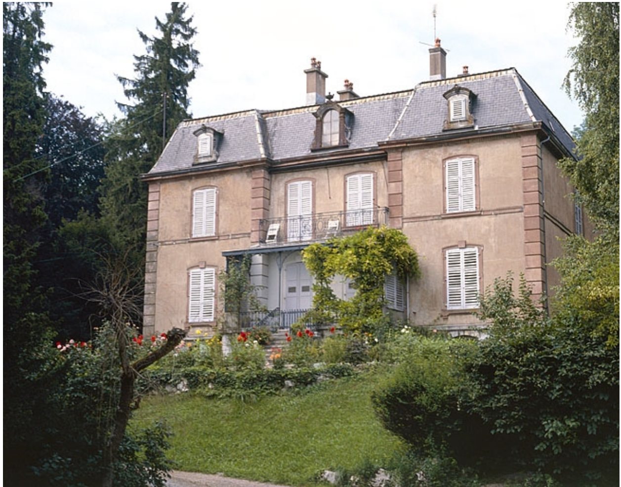
Façade sud du corps de bâtiment principal.
