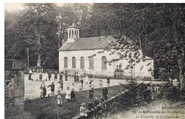
Aillevillers (Hte-Saône) - La Chapelle de la Chaudeau. Phot. Jérôme Mongreville IVR43_20077000086NUCA
