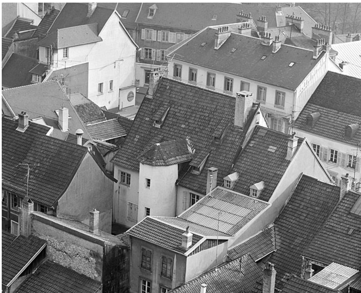
Vue d'ensemble des toitures.
