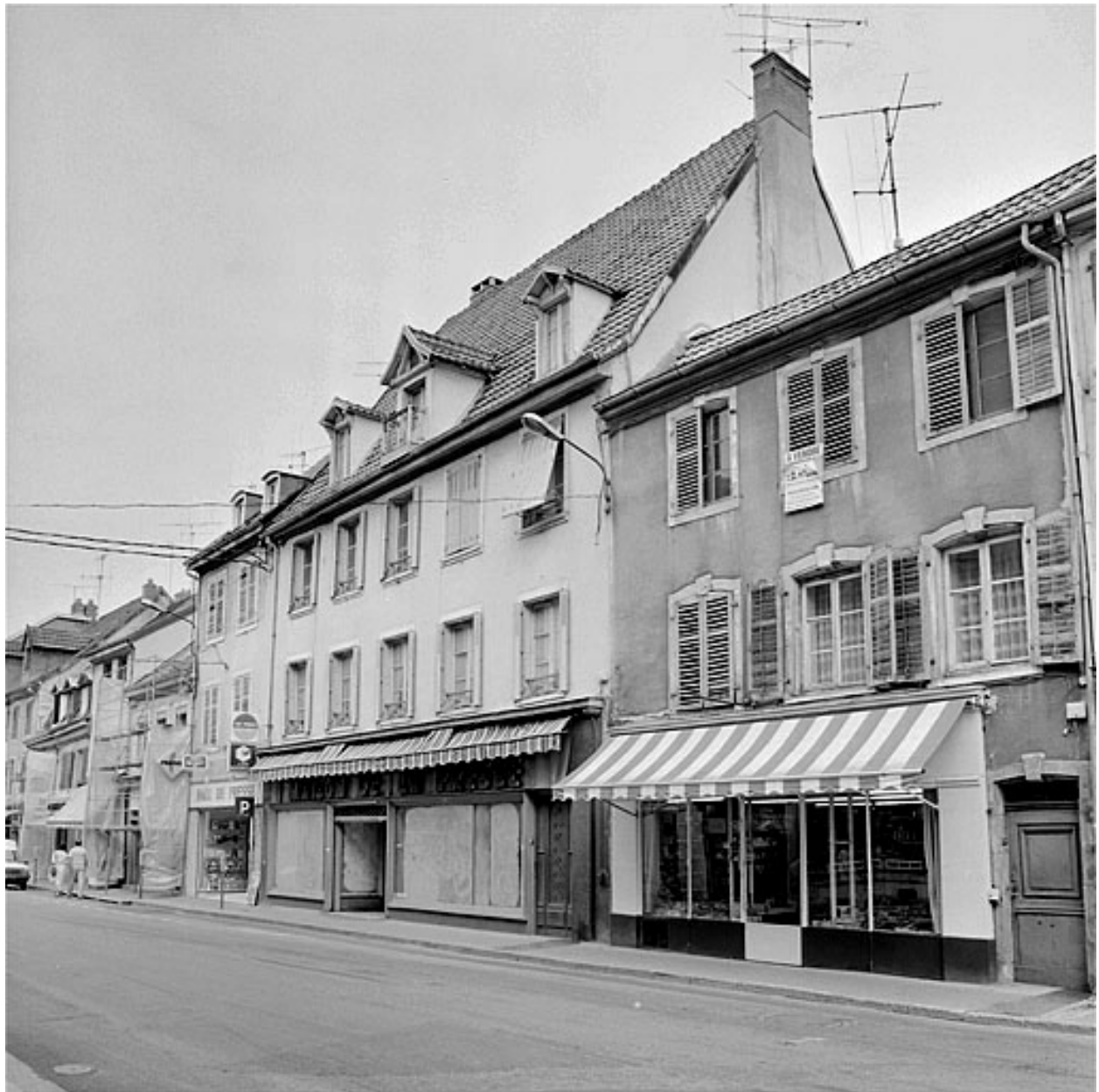
Vue d'ensemble sur la rue.
