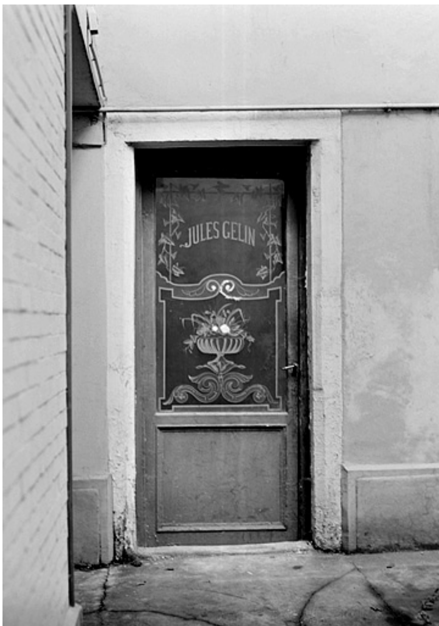
Porte du corps de bâtiment en fond de cour. Sur la vitre figure le nom de Julin Gelin qui tenait un café-concert dans cette demeure à la fin du siècle dernier.
