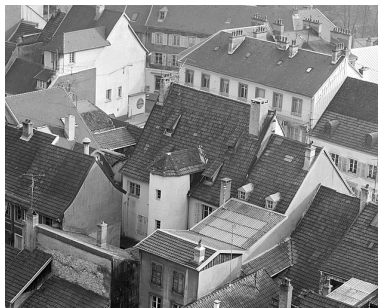
Vue d'ensemble des toitures. Phot. Jérôme Mongreville IVR43_19872501032X
