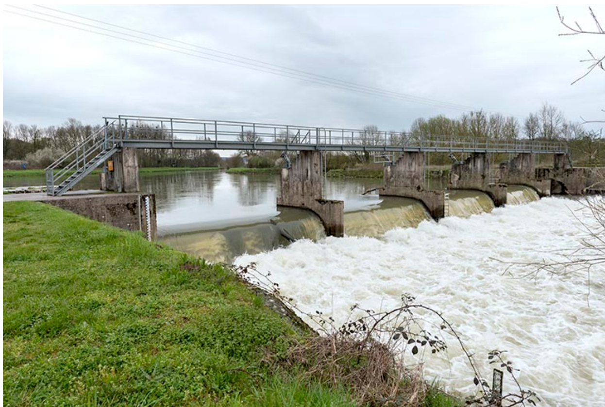
Vue depuis l'aval.
