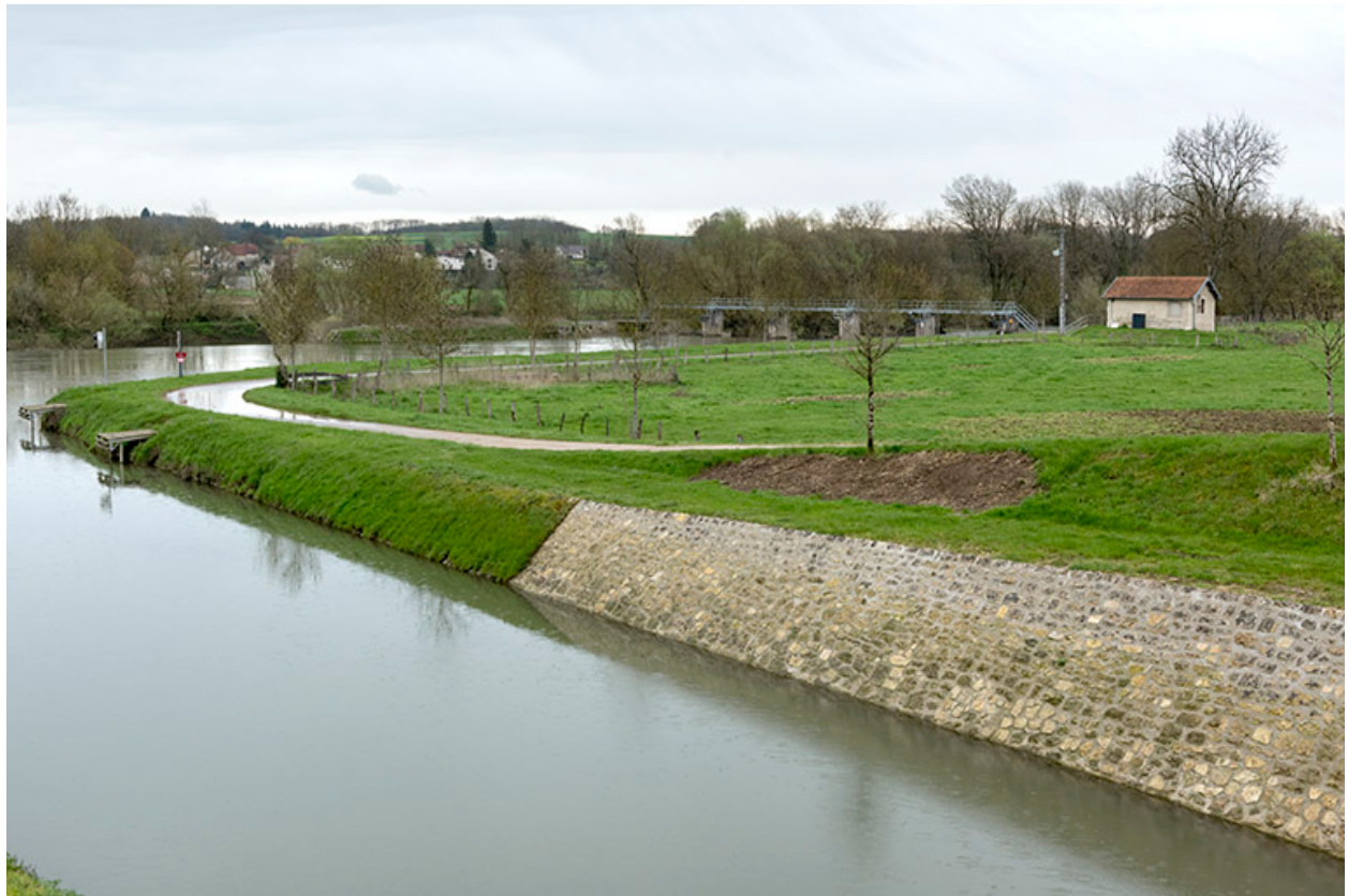
Vue depuis l'entrée amont du canal.
