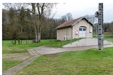
Le magasin à aiguilles. Phot. Sonia Dourlot IVR43_20167000283NUC4A
