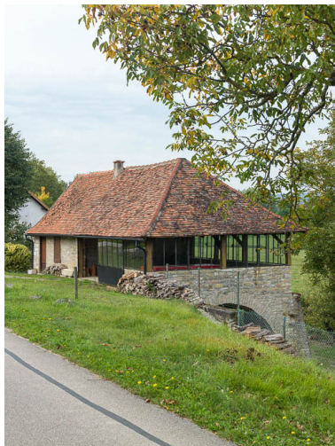
Vue du bâtiment situé en aval. Phot. Pierre-Marie Barbe-Richaud IVR26_20177100412NUC2A
