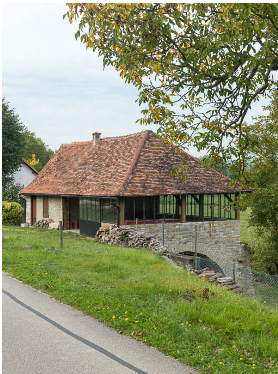
Vue du bâtiment situé en aval.
