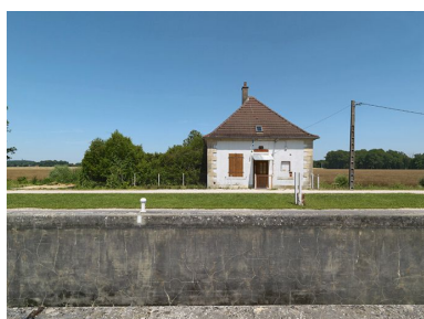
Vue de face. Phot. Thierry Kuntz IVR26_20112103251NUC4A
