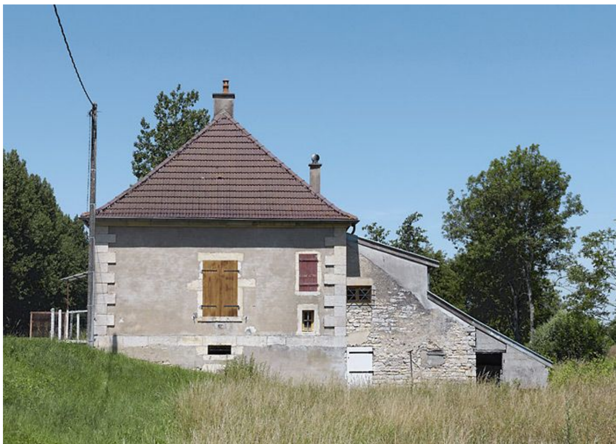
Maison éclusière vue de côté.
