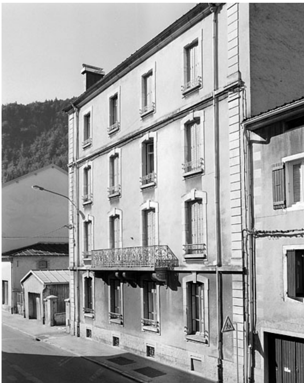
Vue d'ensemble depuis le nord-est : élévation antérieure.
