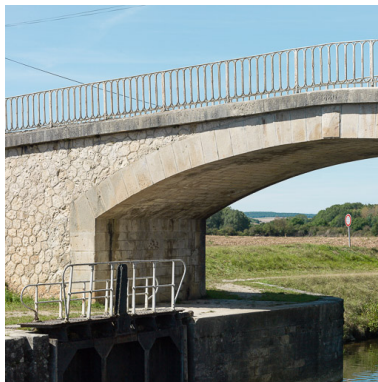
Détail des culées en moellon d'appareil polygonal et de la voûte en anse de panier en pierre. Phot. Pierre-Marie Barbe-Richaud IVR26_20178900206NUC2A
