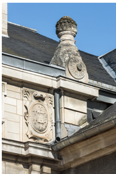
Façade latérale droite, attique : armoiries de la ville et amortissement sur l'angle droit. Phot. Pierre-Marie Barbe-Richaud IVR26_20238900207NUC4A
