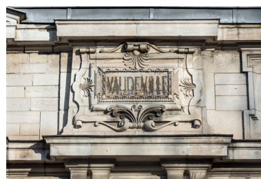
Façade latérale droite, attique : inscription Vaudeville. Phot. Pierre-Marie Barbe-Richaud IVR26_20238900199NUC4A
