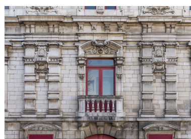
Façade latérale gauche : étage carré. Phot. Pierre-Marie Barbe-Richaud IVR26_20238900156NUC4A
