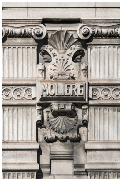
Façade latérale droite, étage carré : inscription Molière. Phot. Pierre-Marie Barbe-Richaud IVR26_20238900206NUC4A
