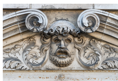
Façade latérale gauche, étage carré : masque de la Tragédie, signature F. Levillain et date 1882. Phot. Pierre-Marie Barbe-Richaud IVR26_20238900149NUC4A
