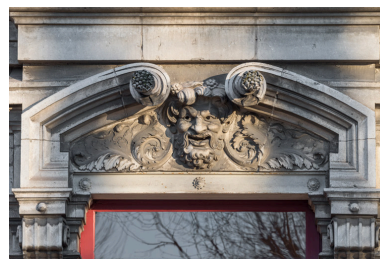
Façade latérale droite, étage carré : linteau avec le masque de la Comédie. Phot. Pierre-Marie Barbe-Richaud IVR26_20238900193NUC4A
