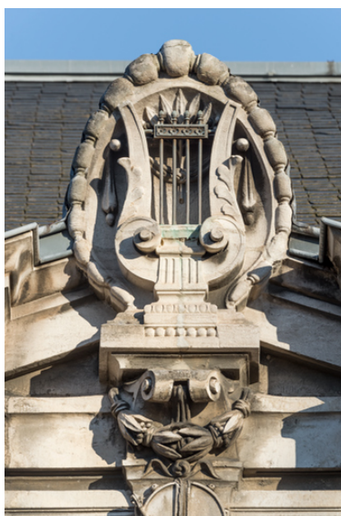
Façade latérale droite, attique : amortissement de la travée centrale. Phot. Pierre-Marie Barbe-Richaud IVR26_20238900198NUC4A
