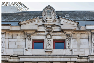
Façade latérale gauche, attique : baies et fronton formant l'amortissement de la travée centrale. Phot. Pierre-Marie Barbe-Richaud IVR26_20238900151NUC4A
