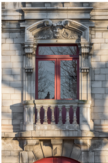
Façade latérale droite, étage carré : baie centrale. Phot. Pierre-Marie Barbe-Richaud IVR26_20238900194NUC4A
