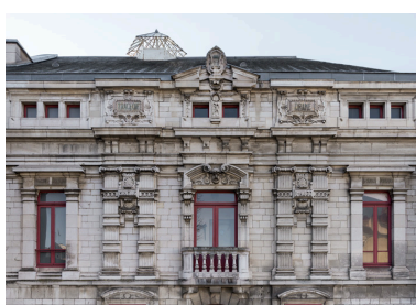
Façade latérale gauche : étage carré et attique. Phot. Pierre-Marie Barbe-Richaud IVR26_20238900155NUC4A
