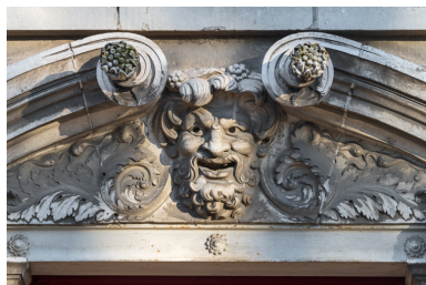
Façade latérale droite, étage carré : masque de la Comédie. Phot. Pierre-Marie Barbe-Richaud IVR26_20238900195NUC4A
