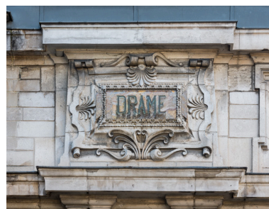
Façade latérale gauche, attique : inscription Drame. Phot. Pierre-Marie Barbe-Richaud IVR26_20238900158NUC4A
