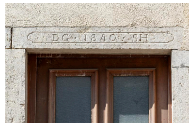
Linteau daté (au n° 6). Phot. Sonia Dourlot IVR43_20192501234NUC4A
