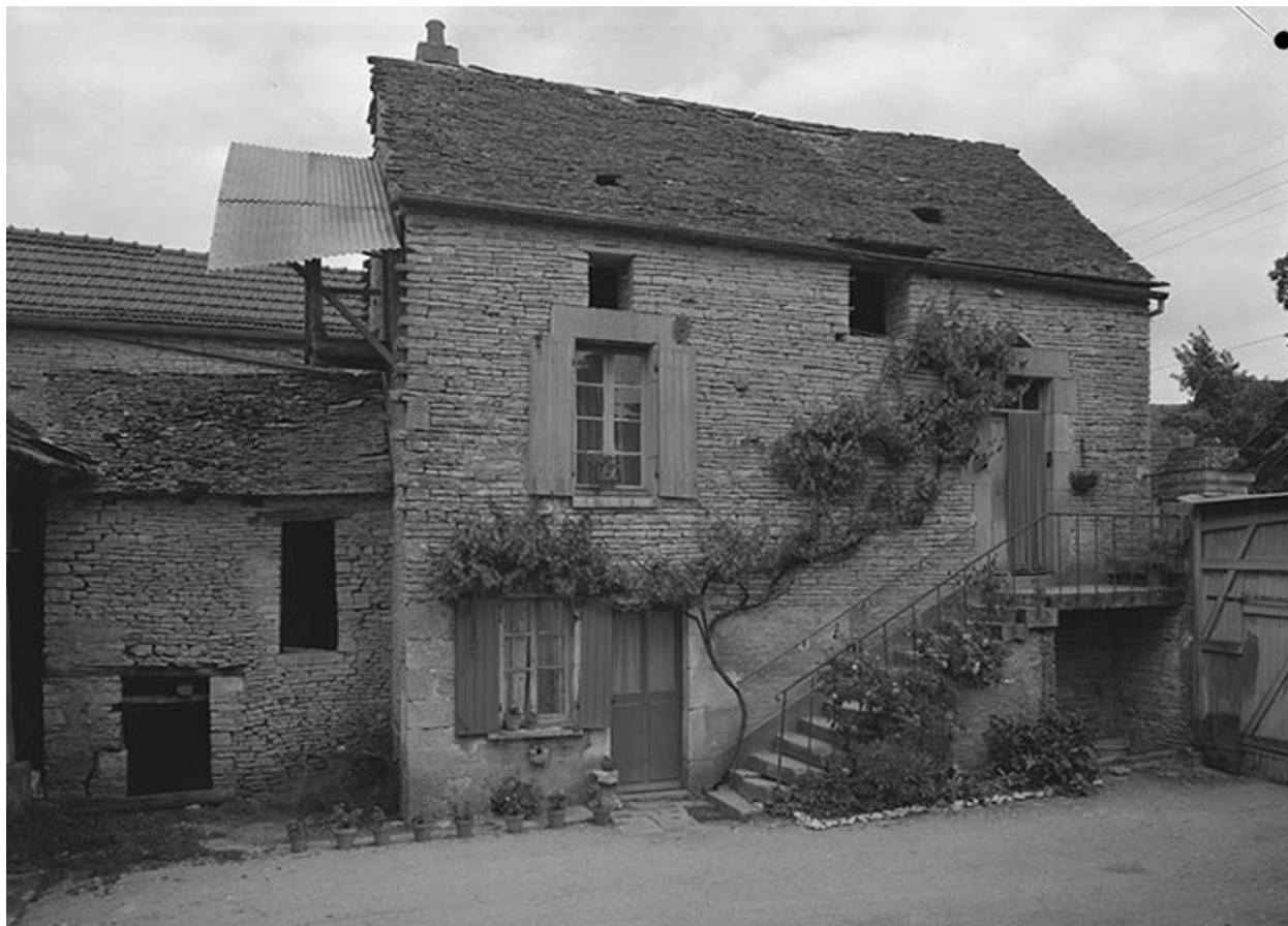
Maison sise parcelle17, section AB, du cadastre de 1958 : façade sur cour.
