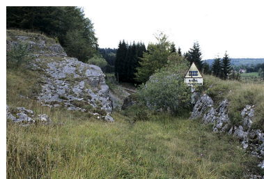
Vue d'ensemble. Phot. Yves Sancey IVR43_20043900229ZA
