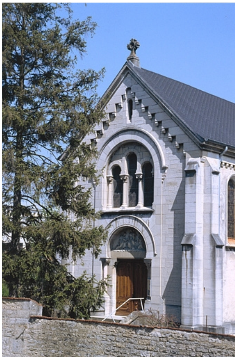
Façade antérieure de la chapelle.
