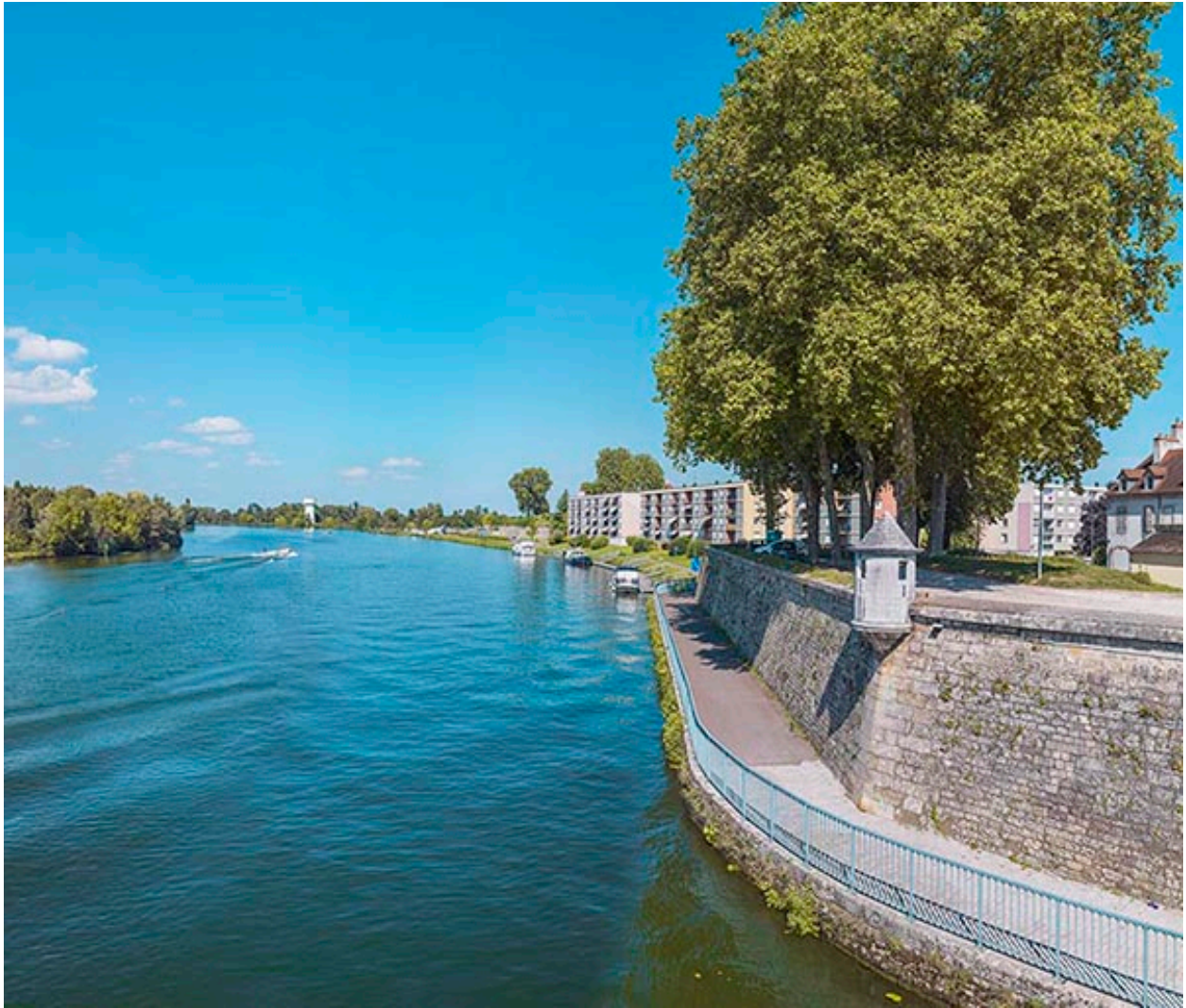
Vue du bastion en amont du pont.
