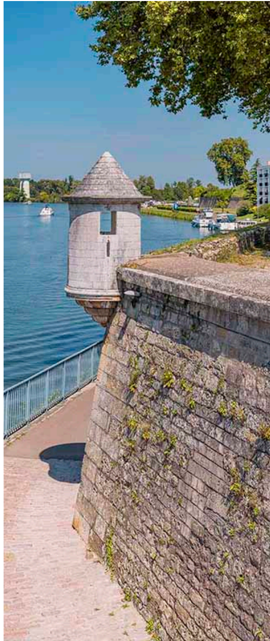
Le bastion prenant appui sur le chemin de halage.
