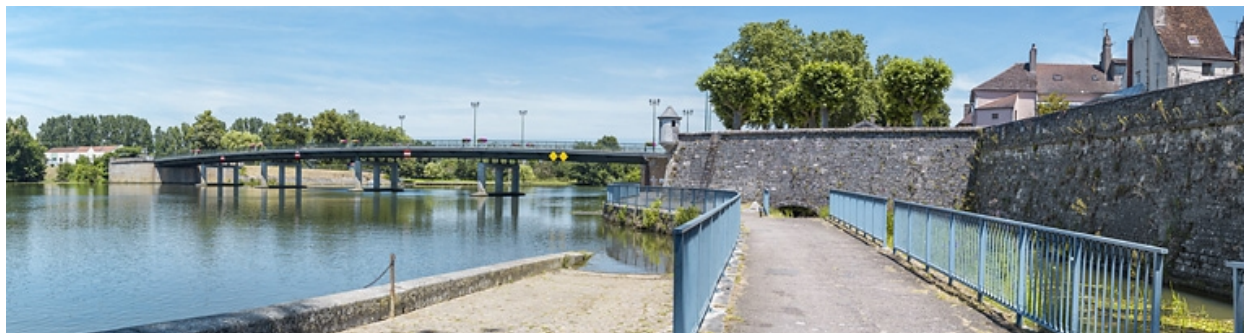
Vue du bastion en aval du pont.
