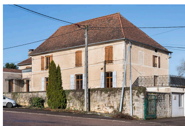
L'orphelinat, façade sud. Phot. Jérôme Mongreville IVR43_20177000096NUC4A
