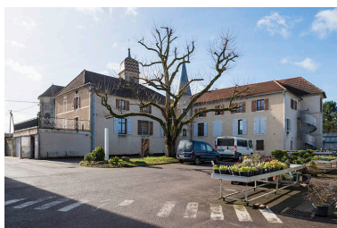
Vue générale depuis le nord-est. Phot. Jérôme Mongreville IVR43_20177000108NUC4A
