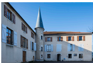
Façades postérieures. Phot. Jérôme Mongreville IVR43_20177000100NUC4A
