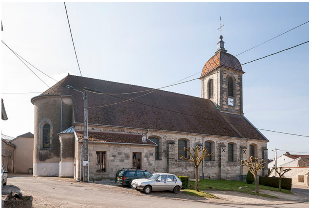
Vue de la façade nord.
