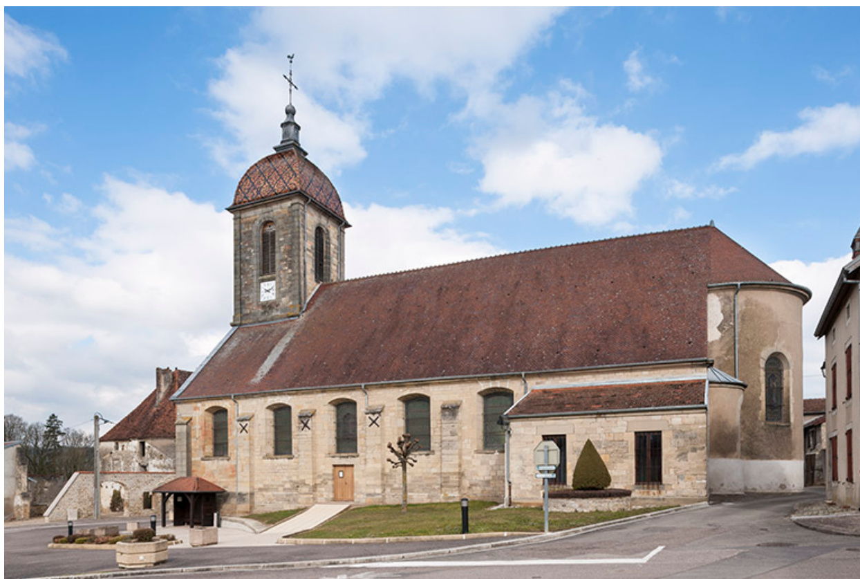
Vue de la façade sud.
