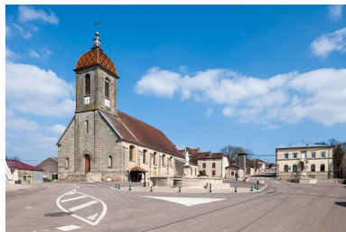
Vue d'ensemble. Phot. Jérôme Mongreville IVR43_20167000479NUC4A
