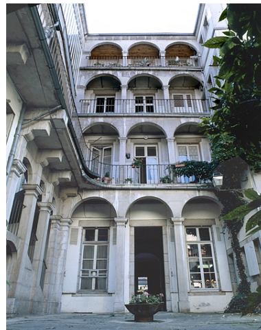
Façade sur la cour. Phot. Yves Sancey IVR43_19883900107XA
