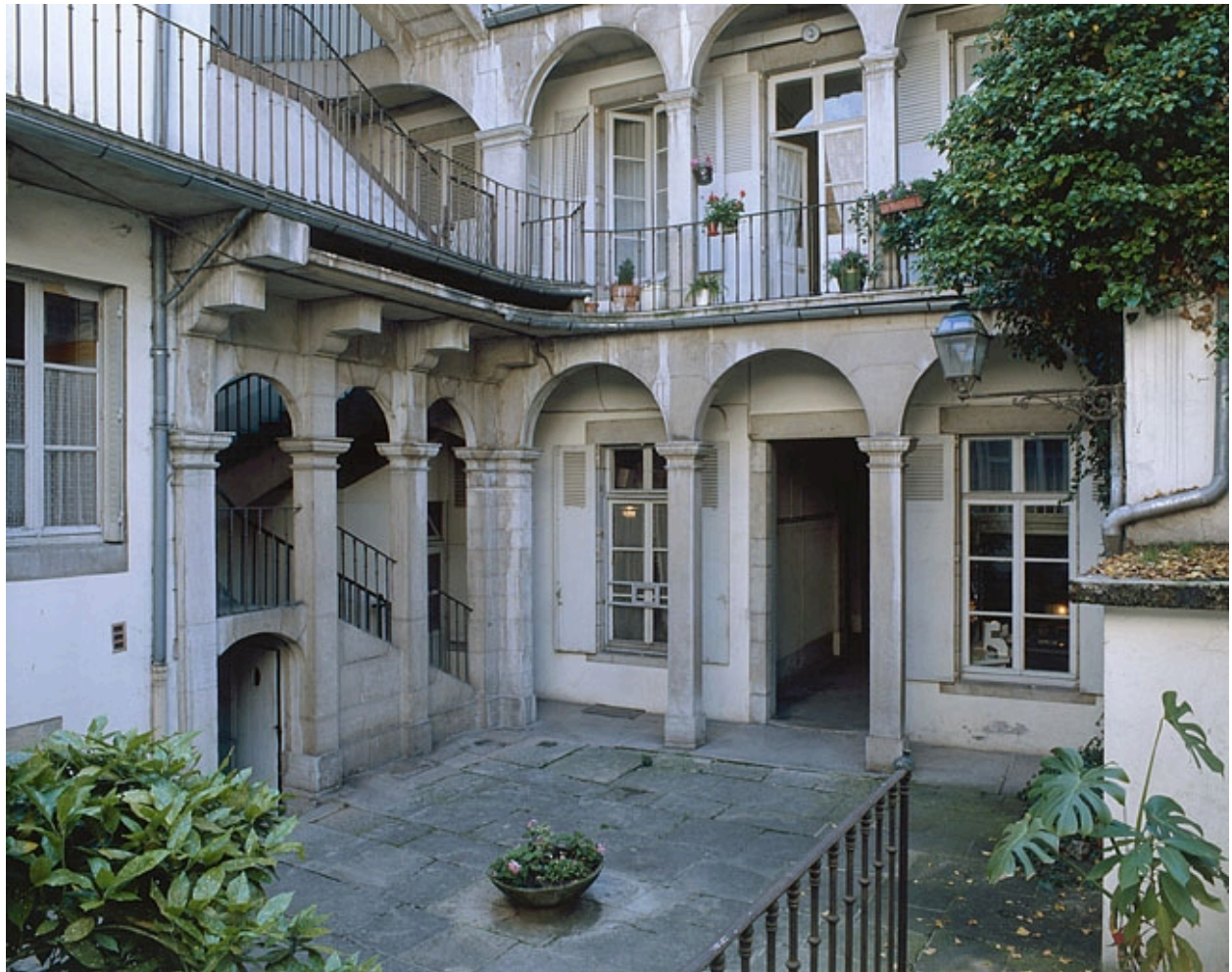
Façade sur la cour, détail.
